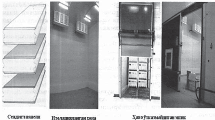
6-расм. Совутиш камерасини ташкил этувчи асосий қисмлар
