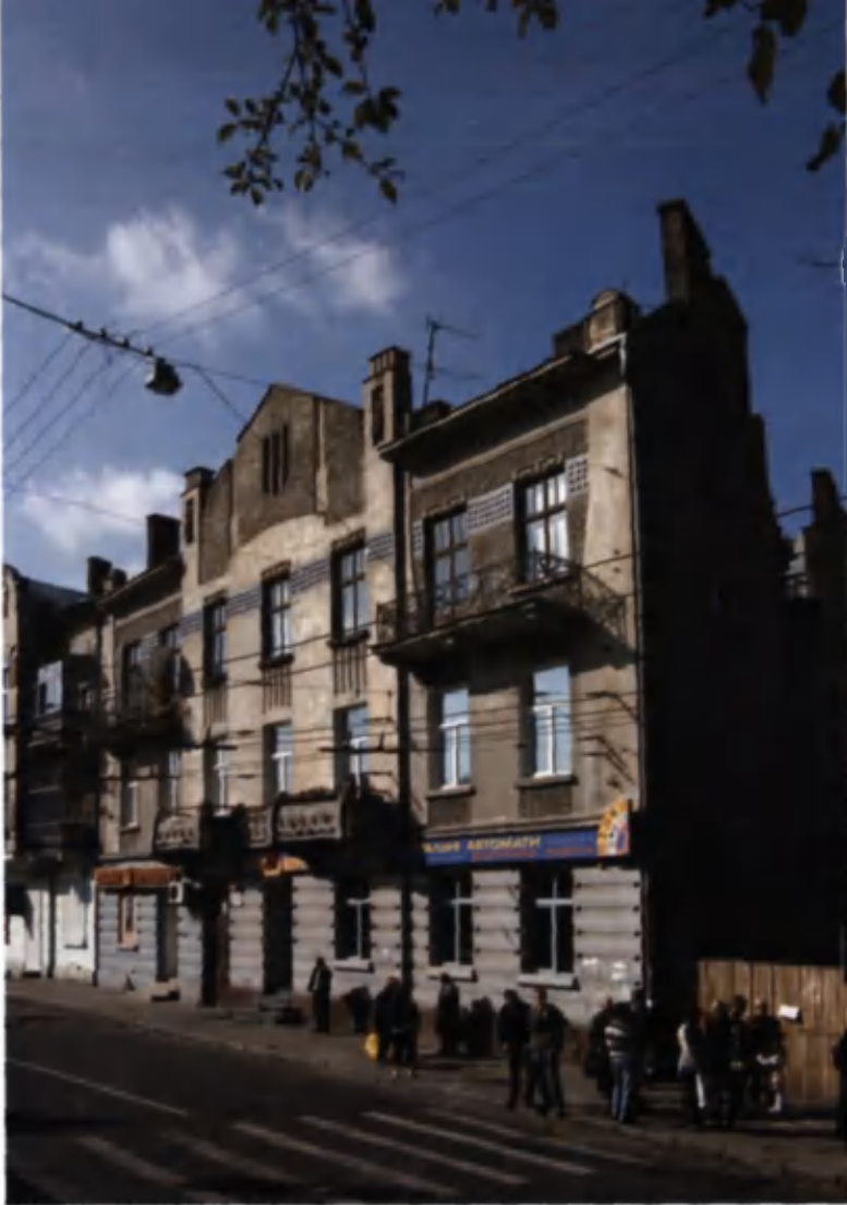
Вул. Руставелі (колишня Яблоновських), 42 (прибуткова кам'яниця І. та З. Мразовіцьких); 1908–1909. Загальний вид.
