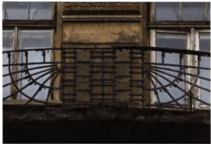
Вул. Богомольця, 5. Балконна решітка.
