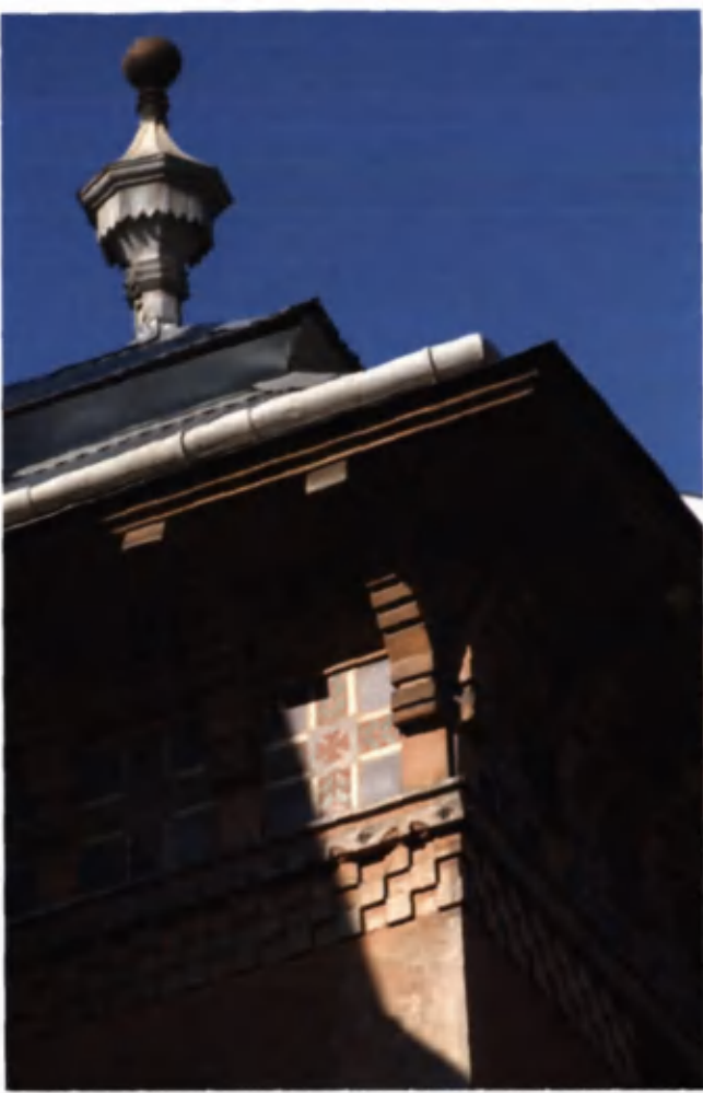
Вул. Лисенка, 14. Дерево й кераміка в декоративному опорядженні покрівлі та карнизу.
