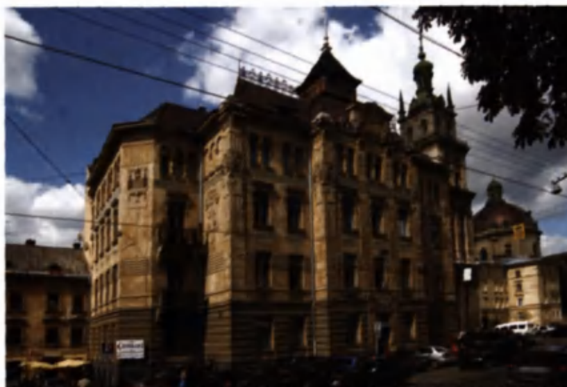
Руська, 20. Фасад з боку вул. Підвальної (східний). На задньому плані – історична архітектура Середмістя.
