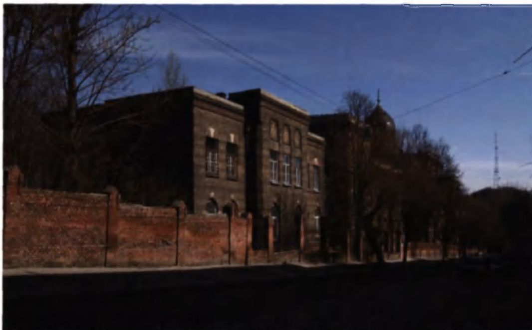
Раппапорта, 8. Чільний фасад. Монументальна будівля займає розlegлу парцелю неподалік від північного краю колишньої другої адміністративної ділянки – Краківського. На сході височіє Замкова гора.
