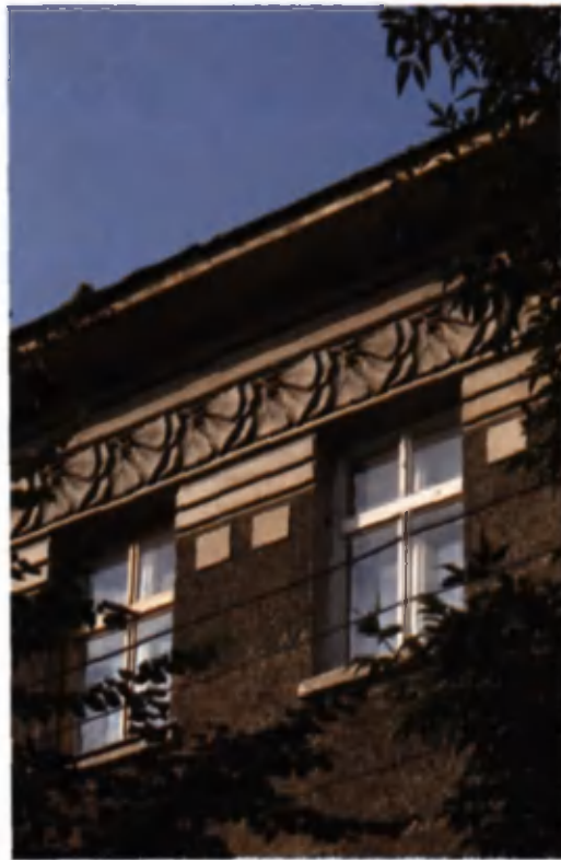
Вул. Хотинська, 3. Декоративні деталі фасаду – ліпний фриз під карнизом, керамічні оздоби на причілку.
