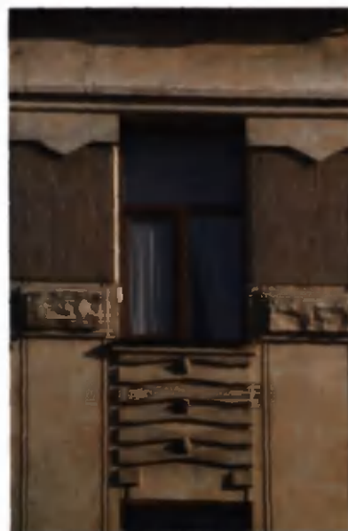
Вул. Бандери, 2 та 6. Опорядження вікон.
