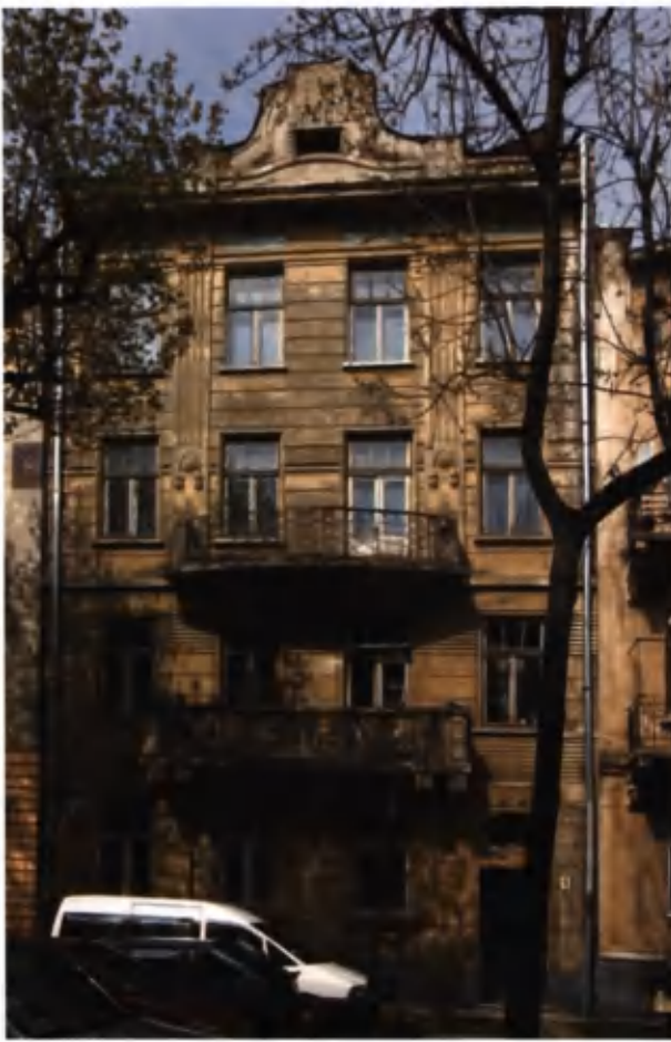
Вул. Богомольця (колишня Асника), 5 (прибуткова кам'яниця І. Левинського); 1905–1906. Чільний фасад.
