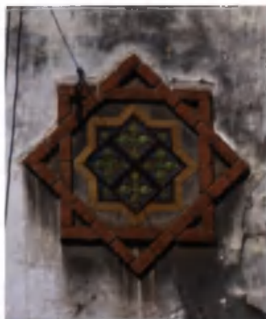
Котляревського, 4. Декоративна розета. Полів'яні кахлі комбінуються з лицювальною цеглою.
