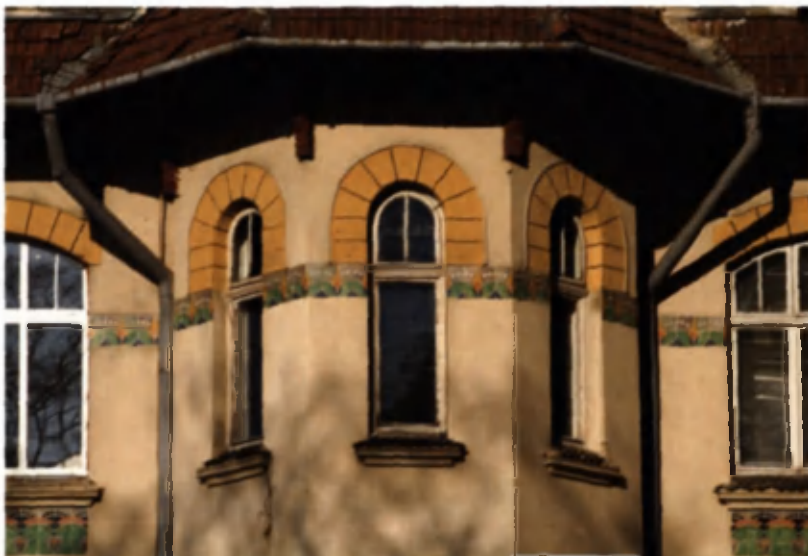
Личаківська, 107. Фрагмент південного фасаду.
