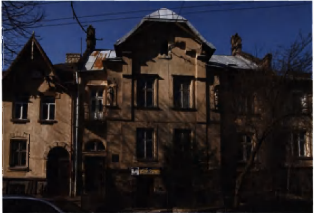
Кольберга, 6. Чільний фасад.
