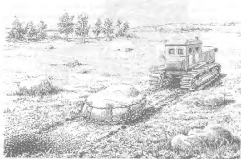
3.1.12-rasm. Katta toshlarni zanjir bilan bog'lab tashish tartibi.
