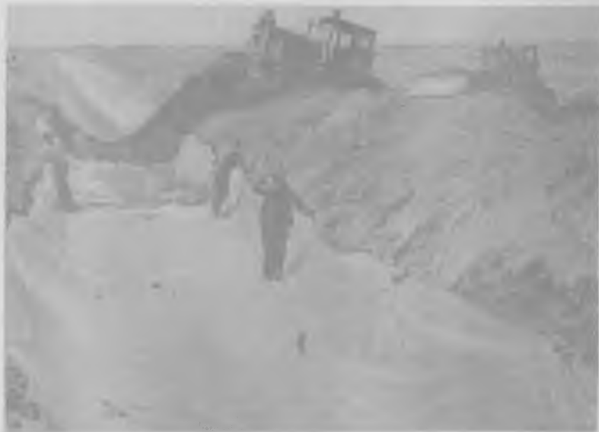
25- расм. Канал тубига полиэтиленли плёнка ётқизиш.
