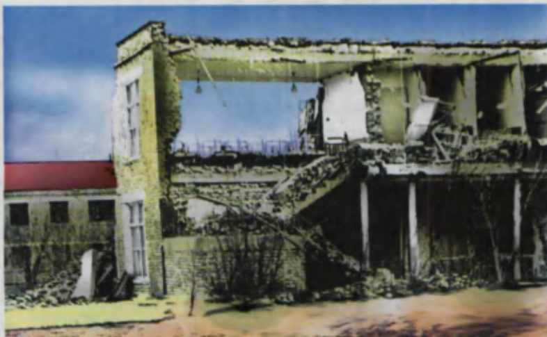
Рис. 11. Разрушенное здание во время землетрясения в Газли в 1976 г.
