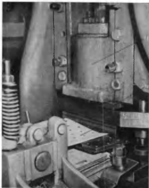
Рис. 89. Пресс со штампом для вырубки отверстий в картоне:
