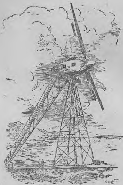
118-рәсм. Шамол тегирмон (чапда) ва қуввати 100 квт булган шамол электр станцияси.
