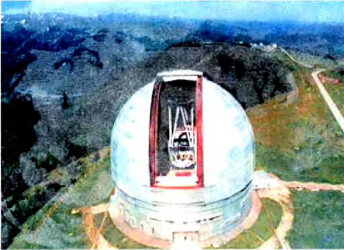
54- rasm. Shimoliy Kavkazda oʻrnatilgan, koʻzgusining diametri 6 metrli teleskop-reflektor minorasining koʻrinishi (ichida teleskopi koʻrinib turibdi).
