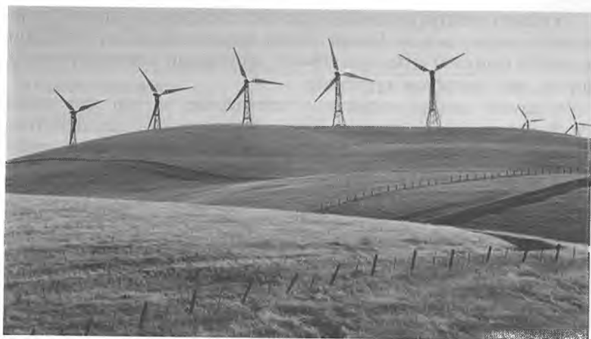
Замонавий шамол электрстанциялари.
