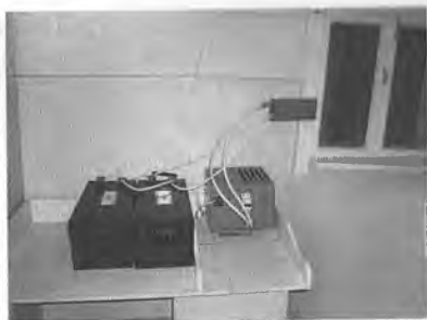
Элликқалъа туманидаги «Чуқурғоқ» ҚВПда KFS-50/12 русумидаги ФЭС қурилмаси ва аккумуляторнинг иш жараёни.
