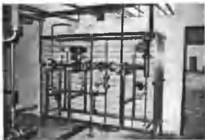
65-rasm. Vakuum bug'lash qozonini bug', suv, va siqilgan havo bilan ta'minlash sistemasi.
