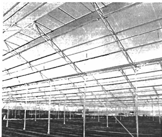
4.76-rasm. Issiqxonaning yuqoridan shamollatish tizimi. Elektr sim yordamida avtomat turida o'tkaziladi
