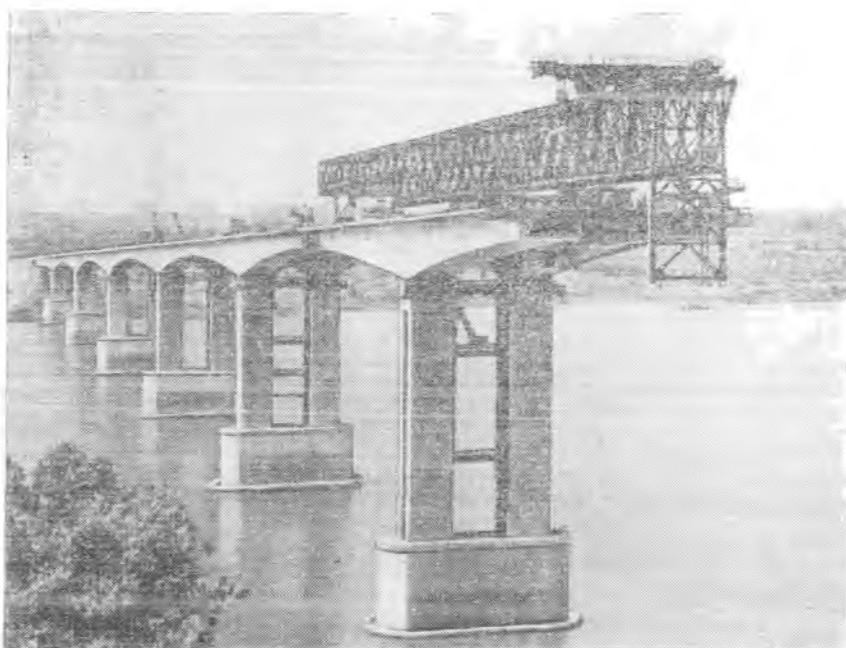
Рис. 1.4. Монтаж неразрезных пролетных стропильных пролетом по 128 м 60-тонным краном
