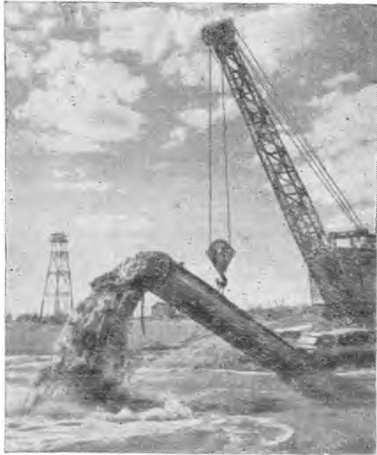
Рис. 53. Укладка труб при безэстакадном способе намыва
