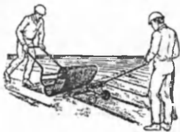
10.1-rasm. Eritiladigan ruberoid asosida tomni gidroizolatsiyalash.
