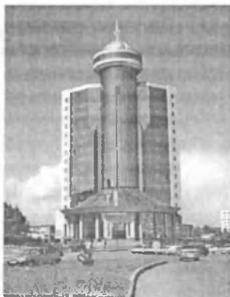
7.9-rasm. Toshkent shahrida monolit qurilgan Banklar assotsiatsiyasi binosi.
