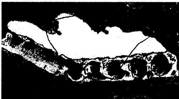
Рис. 7.5. Отверстие, пробитое в пустотах плиты перекрытия для пропуска коммуникаций (из семи ребер перебито пять)
