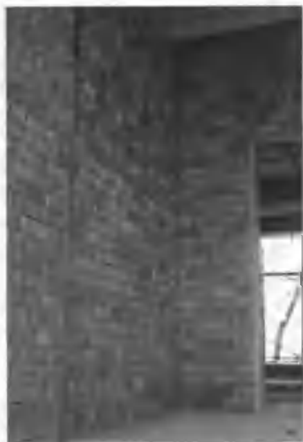
1.86-rasm. Zilzilabardosh qilib ko'tarilgan g'ishtli pardevorlar.
