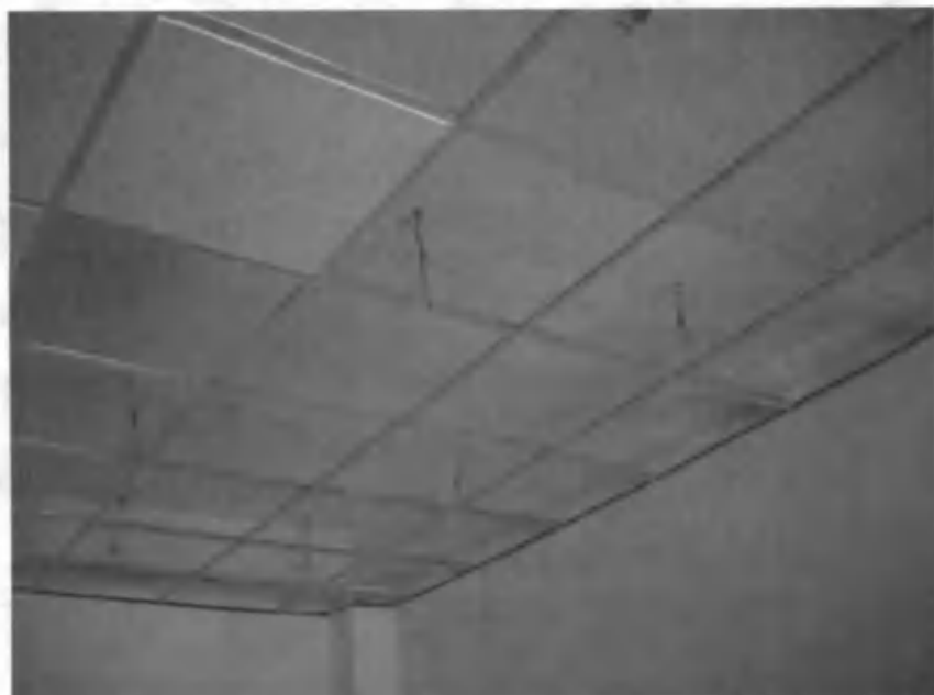
1.101-rasm. Armstron materialidan ishlanadigan shiftning alumin karkasi.
