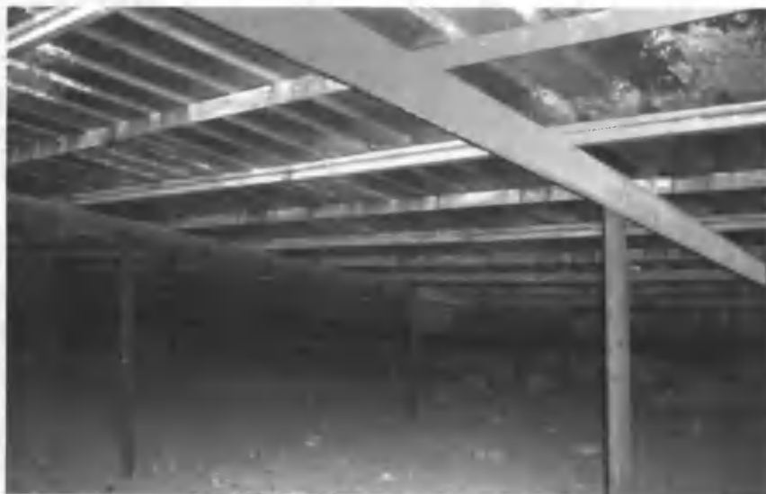
1.52-rasm. Ko'taruvchi konstruksiyalari metall prokatlar (shveller)dan ishlangan profnastilli tomning umumiy ko'rinishi.
