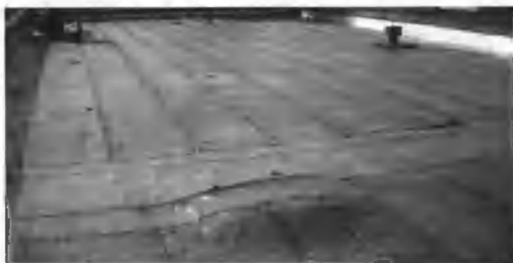
1.47-rasm. Folgaizolning tomda krovli sifatida qo'llanilishi.
