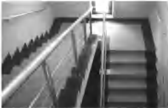
1.109-rasm. Turar joy binosida qo‘llanilgan ikki marshli zinapoyaning bir qismi.
