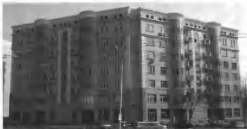
1.24-rasm. Kompleks konstruksiyalar (pishgan g'isht va quyma temir-beton)dan ishlangan zilzilabardosh turar joy binosining umumiy ko'rinishi (Toshkent shahri).
