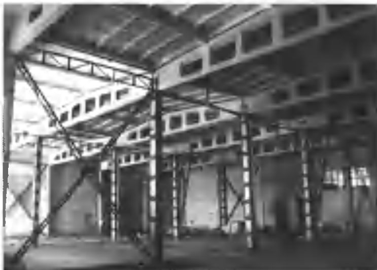
3.29-rasm. Ustunlarda xoch, balkalarda ferma ko'rinishidagi bog'lamalar va tortmalarning amaliyotda qo'llanilishi.
