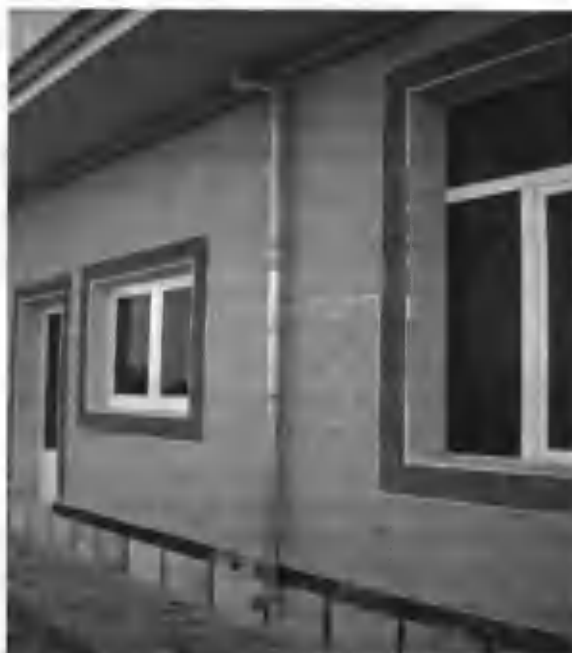
1.76-rasm. Tomdan suvni qochirish uchun tushirilgan po‘lat tunukadan tayyorlangan devorga yopishgan quvur.
