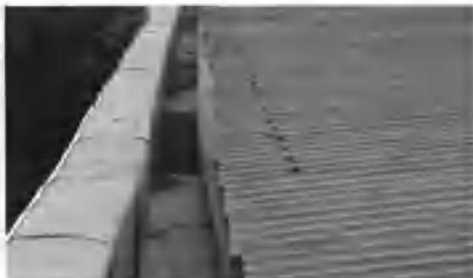
1.77-rasm. Profnastildan ishlangan krovli tarnovi.
