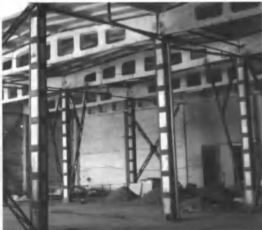
2.15-rasm. Ustunlarni metall burchakliklar va plastinalar yordamida kuchaytirish.
