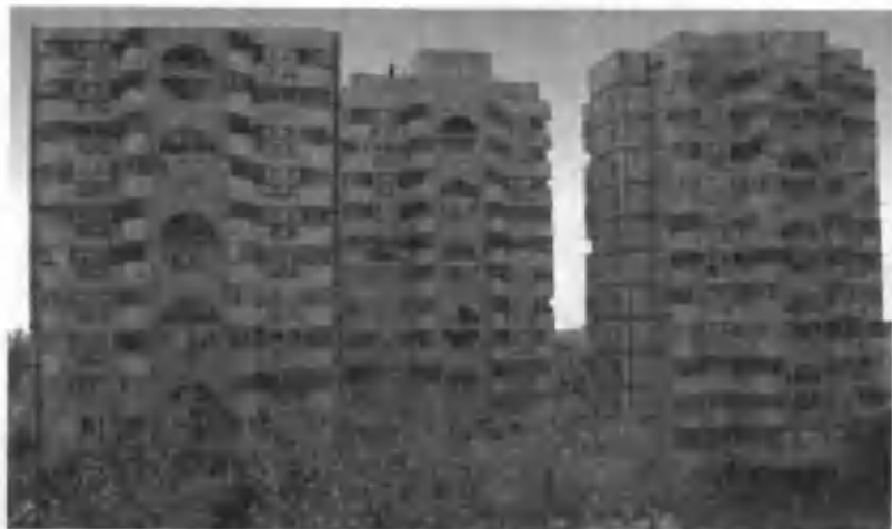
1.6-rasm. Yirik panelli temir-betondan (sinchsiz) qurilgan Toshkent shahrining Ohunboboyev maydonidagi turar joy binolarining umumiy ko'rinishi.
