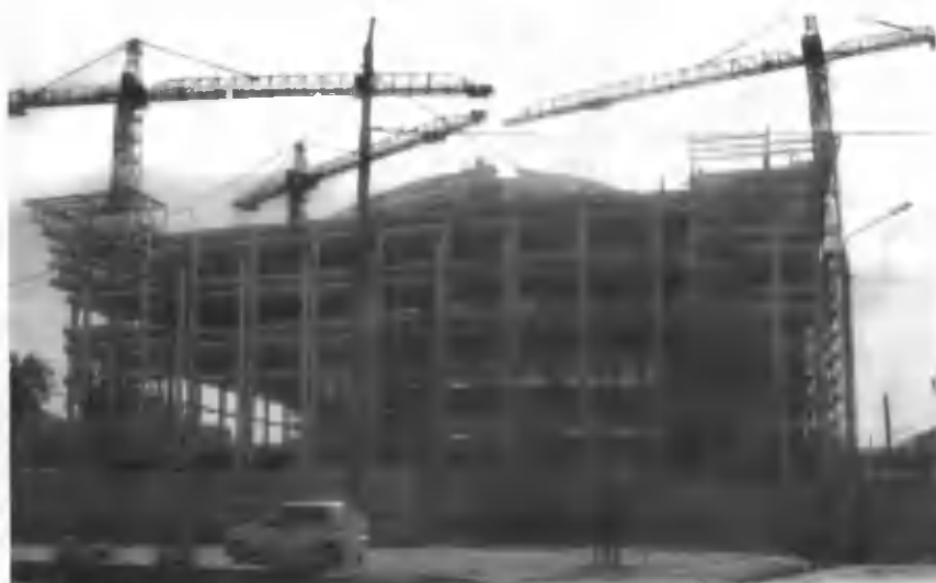
1.4-rasm. Sinchli konstruksiyada metallidan ishlangan Toshkentdagi «O'zbekiston» xalqaro anjumanlar saroyining qurilish davridagi umumiy ko'rinishi.
