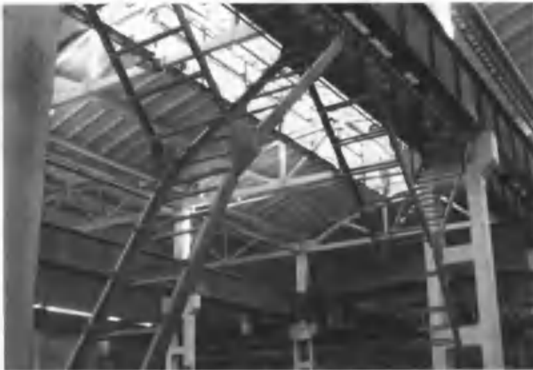
3.30-rasm. Ustunlarda poligonal ko'rinishdagi bog'lamalarning amaliyotda qo'llanilishi.
