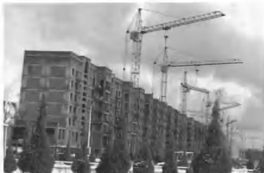
1.5-rasm. Kompleks konstruksiyalardan (sichsiz) ishlangan Toshkentning Alisher Navoiy ko'chasidagi zamonaviy ko'p qavatli turar joy binolarining qurilish davridagi umumiy ko'rinishi.
