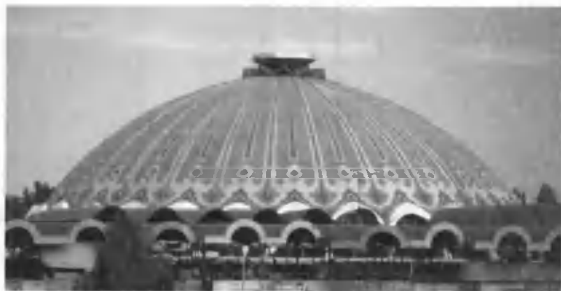
1.7-rasm. Qobiqli konstruksiyadan qurilgan Toshkentdagi «Chorsu» bozori binosining umumiy ko'rinishi.
