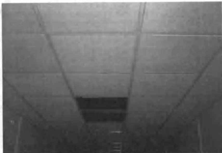
1.100-rasm. Xona shiftining umumiy ko'rinishi.
