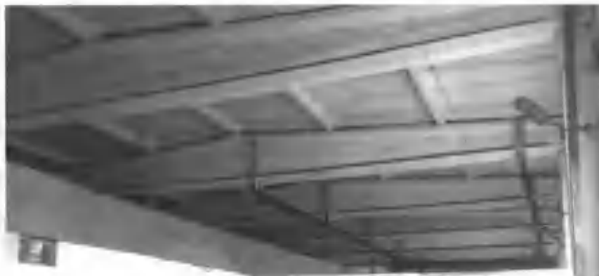
3.12-rasm. Yaxlit kesimli yig‘ma temir-beton yopma to‘sinlarning amaliyotda qo‘llanilishi.
