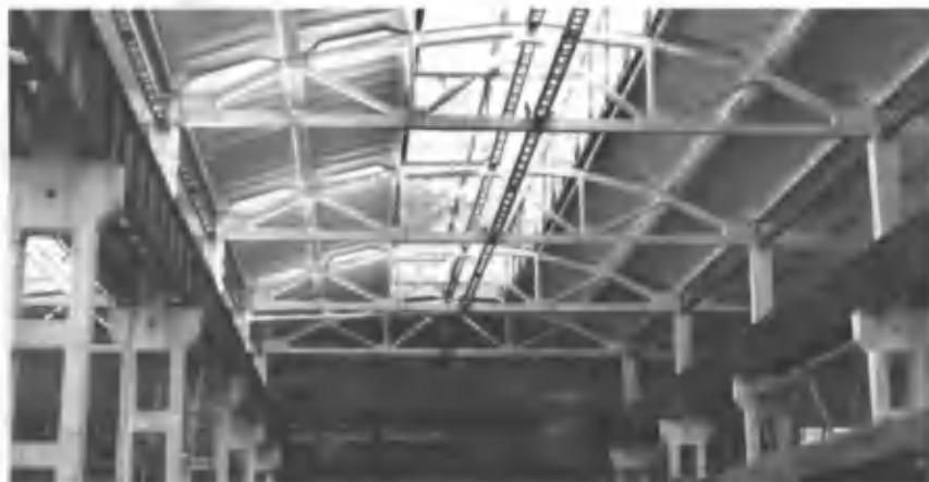
3.13-rasm. Yig‘ma temir-beton fermalarning amaliyotda qo‘llanilishi.
