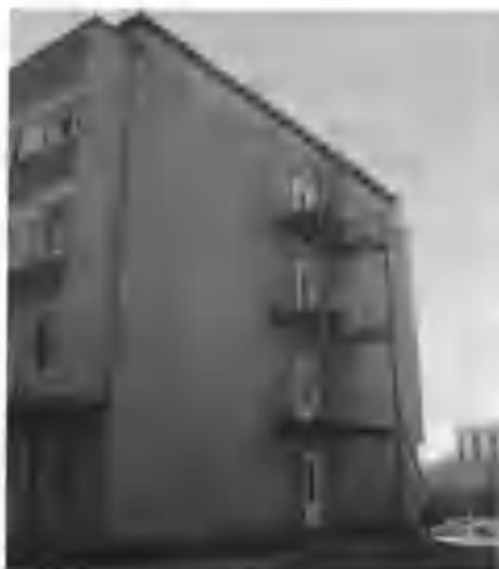
1.110-rasm. Favquloddagi holatlarda ishlatiladigan qo'shimcha zinapoya.
