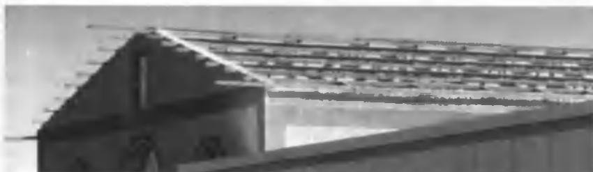
1.51-rasm. Ko'taruvchi konstruksiyalari yog'ochdan ishlangan ikki nishabli tomning umumiy ko'rinishi.
