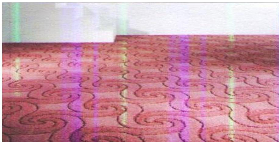
13.11 - расм. Грифтал линолеум асосли иссиқ сақловчи гилам
