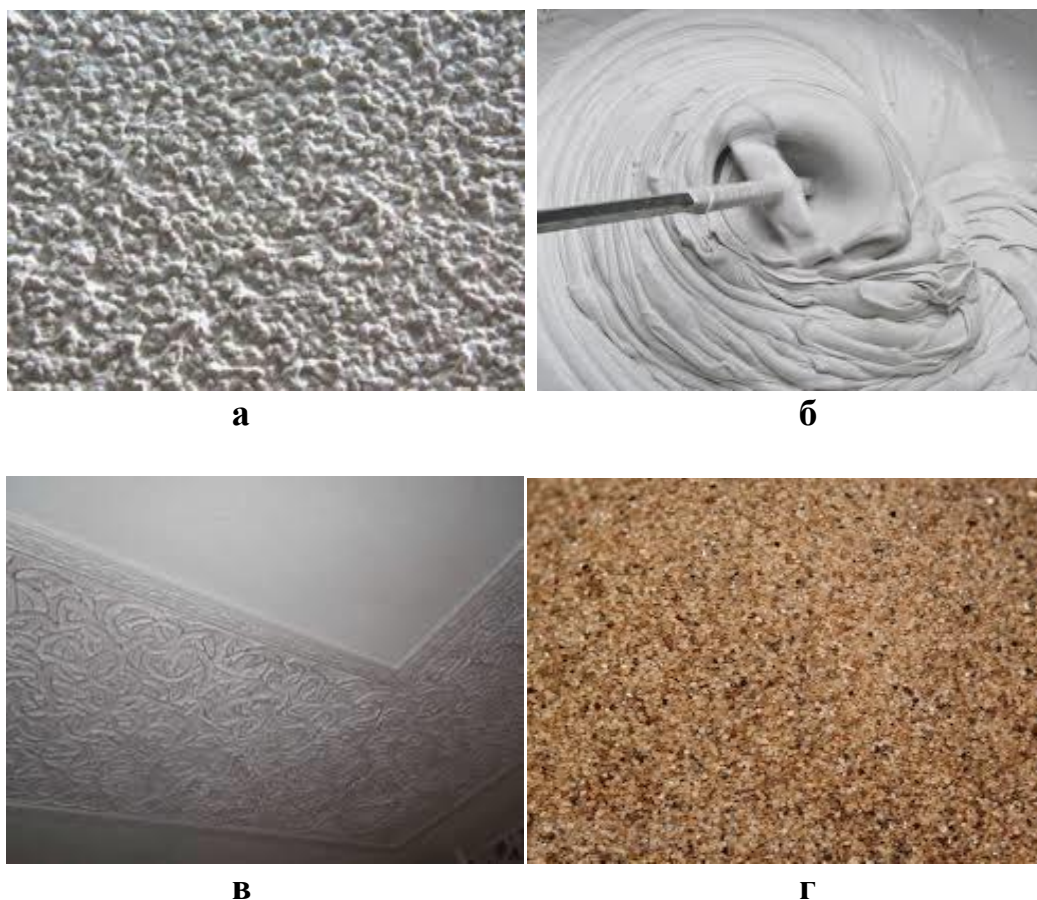
10.7 - расм. Махсус қоришмалар асосидаги сувоклар. а-торкретлаш усулида суваш; б-инъекцион қоришма; в-акустик пардозли сувок; г-рентген нуридан химояловчи сувок.
