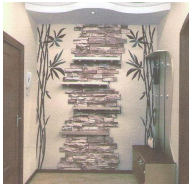
3.7 – расм. Хона девори (а) ва эшиклар атрофини (б) табиий тошлар билан пардозлаш.
