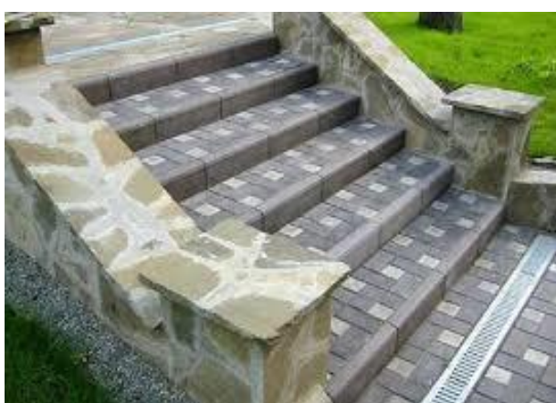
Бетон плиткали зинапоя конструкцияси
