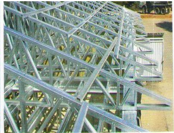
Том фермаси конструкцияси
