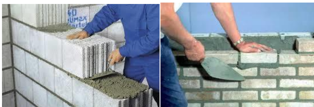
10.2 - расм. Териш қоришмалари. а- ғиштли деворларни териш учун; б-девор блокларни териш учун.
