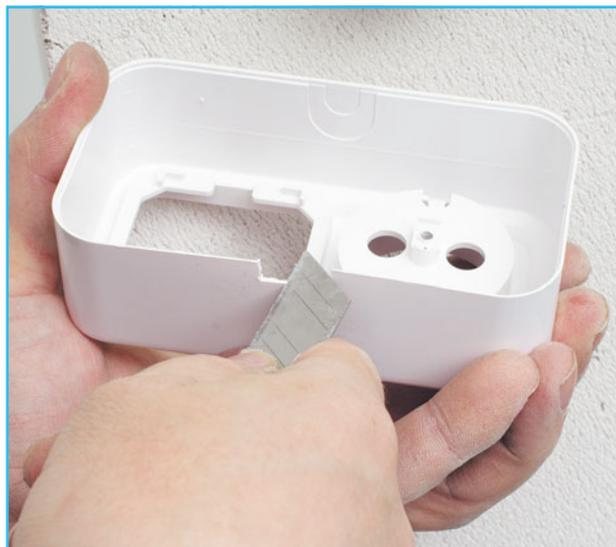
**9** Прорезаем отверстие в корпусе розетки. Обычно это делают строительным ножом, в особых случаях — ножовкой по металлу.
