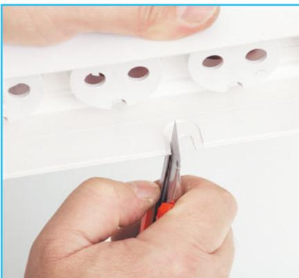
**13** Вырезаем в корпусе блока розеток отверстие под провод строительным ножом.
