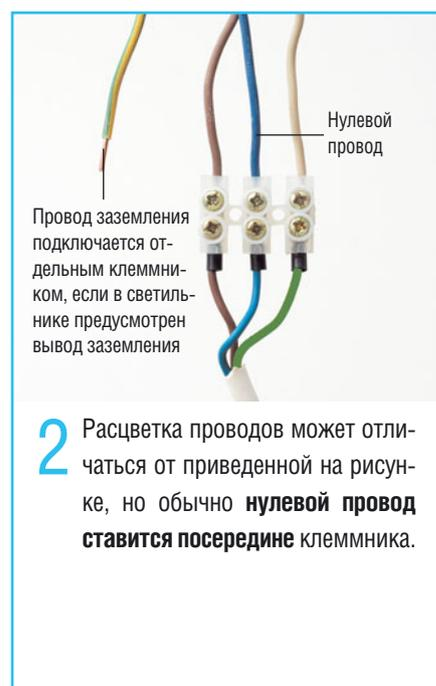
**2** Расцветка проводов может отличаться от приведенной на рисунке, но обычно **нулевой провод ставится посередине клеммника.**
