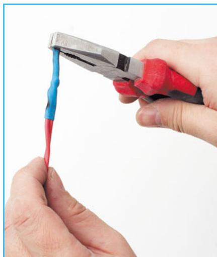
**5** Пока трубка горячая, зажимаем ее край: таким образом он склеивается, предотвращая попадание влаги внутрь соединения.
