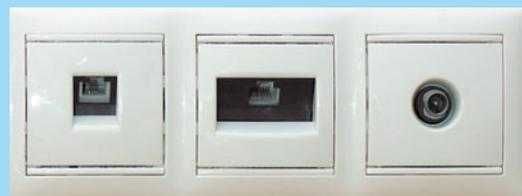
Иногда в одном корпусе объединяют телефонные, компьютерные и антенные разъемы.
