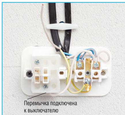
**7** Подключаем второй конец перемычки к выключателю.
