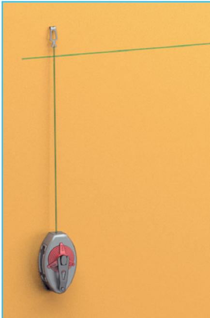
**1** Размечаем стену с помощью отбивки — окрашенной нити (можно использовать вместо нити лазерные уровни — нивелиры).
