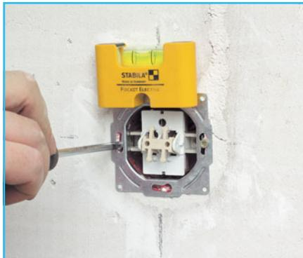
**7** Устанавливаем выключатель в подрозетник. Действия аналогичны установке одиночной розетки (см. с. 165–166).
