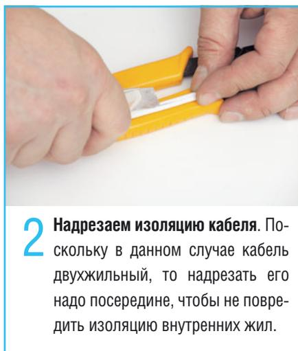
**2** Надрезаем изоляцию кабеля. Поскольку в данном случае кабель двухжильный, то надрезать его надо посередине, чтобы не повредить изоляцию внутренних жил.
