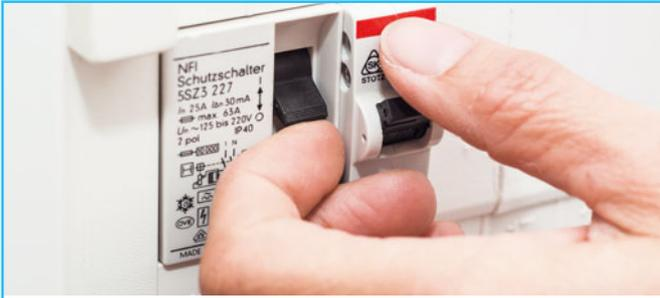
**Обязательно установите в сети защитные устройства отключения** — пробки, плавкие вставки, предохранители, автоматические выключатели, а также дифференциальные автоматы (но никак не самодельные «жучки»). В их исправности не должно быть никаких сомнений.
