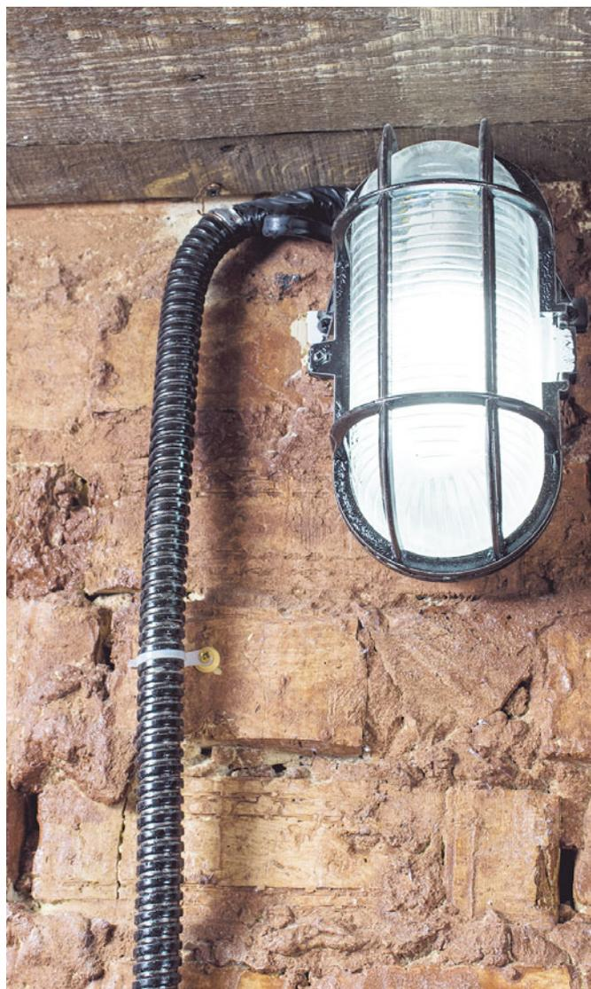
На чердаке электрические провода укладывают в металлические гофрированные трубы
