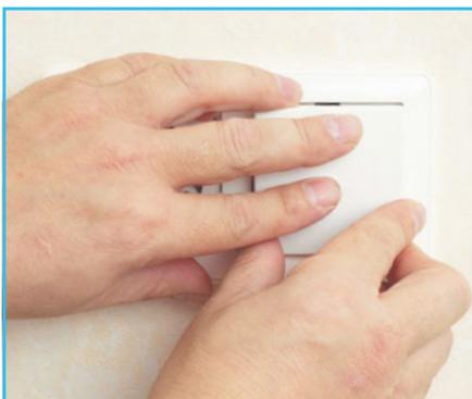
**8** Устанавливаем клавиши выключателя на место.
