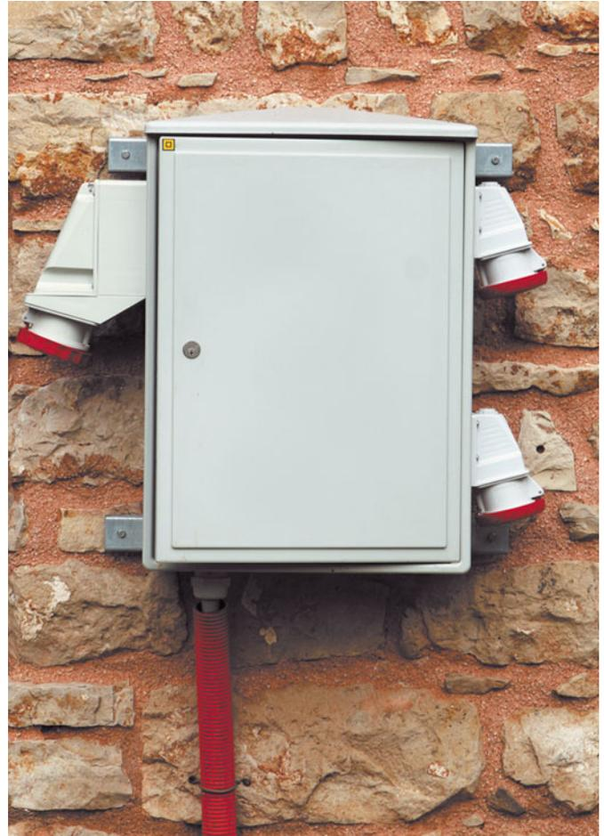
Наружный герметичный щит, на корпусе — силовые разъемы: трехфазный (слева), однофазные (справа)
