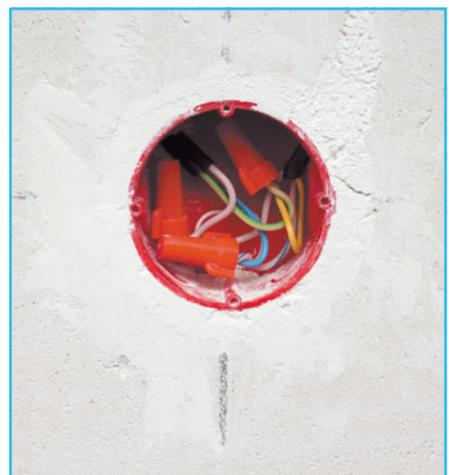
**6** Укладываем соединения в подрозетник. Теперь можно закрыть подрозетник пластиковой крышкой и ровнять стену штукатуркой.
