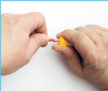
**12** Накручиваем СИЗ до упора. Это можно почувствовать, когда колпачок перестает продвигаться по скрутке.
