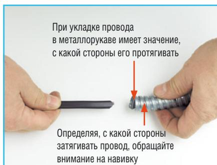
**2** **Протягиваем провод** с той стороны, где металлорукав напоминает воронку. Определяя, с какой стороны затягивать провод, обращайте внимание на навивку
