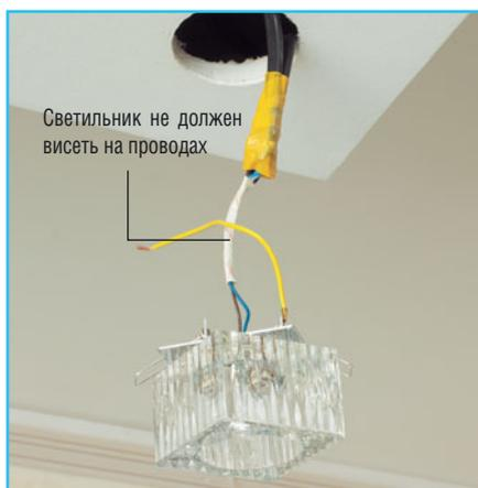
**4 Вытащив светильник,** просим кого-нибудь его **поддержать**, чтобы он не висел на проводах.
