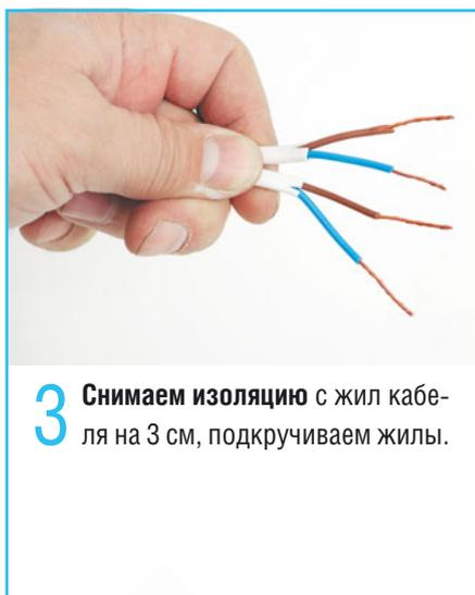
**3** Снимаем изоляцию с жил кабеля на 3 см, подкручиваем жилы.
