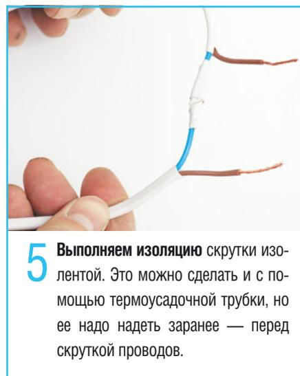
**5** Выполняем изоляцию скрутки изолентой. Это можно сделать и с помощью термоусадочной трубки, но ее надо надеть заранее — перед скруткой проводов.
