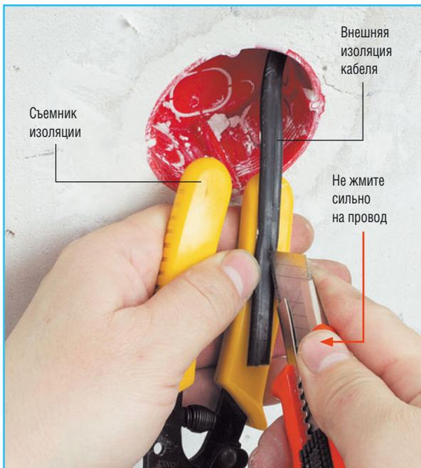
**1** **Надрезаем внешнюю изоляцию** кабеля. Поскольку кабель трехжильный, то надрез необходимо делать на расстоянии около  $\frac{1}{3}$  ширины от края. Если кабель двухжильный, его следует надрезать посередине — так вам удастся не повредить изоляцию внутренних проводов кабеля.
