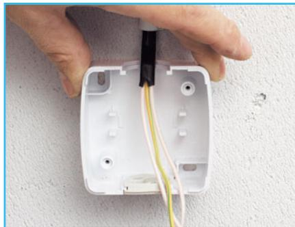
**3** Подгибаем провод так, чтобы он не мешал установке розетки.
