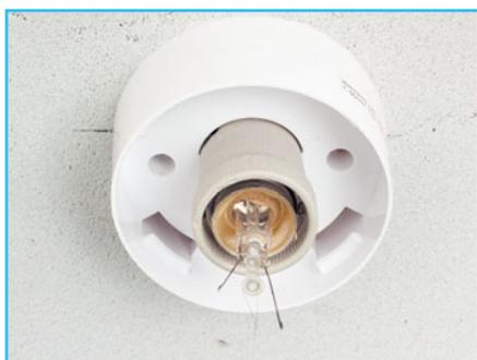
**1** Обесточиваем светильник. Индикаторной отверткой проверяем отсутствие напряжения на усиках лампы.
