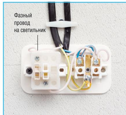
**8** Подключаем фазный провод, который идет на светильник. Если выключатель двухклавишный, то на светильник подсоединяют два провода.
