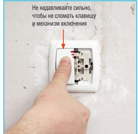
**11** Вставляем первую клавишу. Следим за тем, чтобы она была установлена в специальный крепеж, предназначенный именно для нее.
