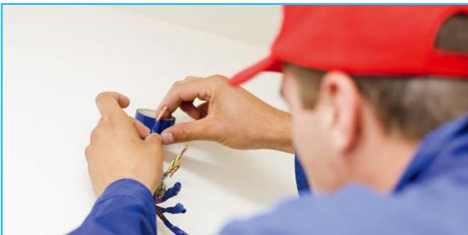
**Изолируйте ненужные провода** во время работы, чтобы они не стали причиной короткого замыкания. Выполняйте соединение проводов и кабелей пайкой, сваркой, опрессовкой и специальными зажимами очень тщательно. Самостоятельно соединяйте и оконцовывайте проводники лишь в том случае, если вы уверены, что сделаете это правильно.
