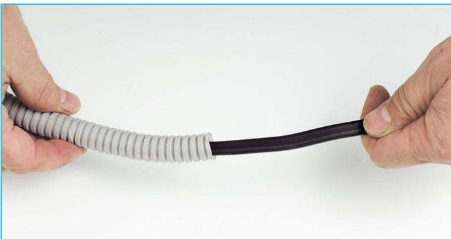
**3** **Протягиваем провод** так, чтобы он вышел с другой стороны гофры. Иногда гофра продается вместе с протяжкой. В этом случае (особенно если гофра длинная и провод сам может не пойти) нужно закрепить протяжку на проводе и тащить ее с противоположного конца гофры.
