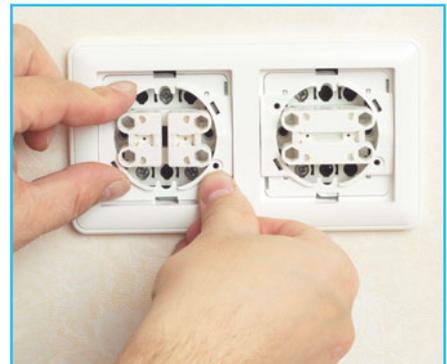
**7** Устанавливаем рамку, используя фиксаторы.
