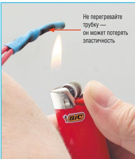
**4** С помощью зажигалки нагреваем трубку. Со строительным феном изоляция получается аккуратнее.
