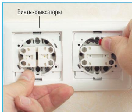
**2** Снимаем рамку выключателя, предварительно разжав винты-фиксаторы.
