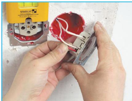
**8 Подключаем провода** ко второй розетке. Следим, чтобы два провода подводящего кабеля были прикручены к разным клеммам розетки, иначе произойдет короткое замыкание.
