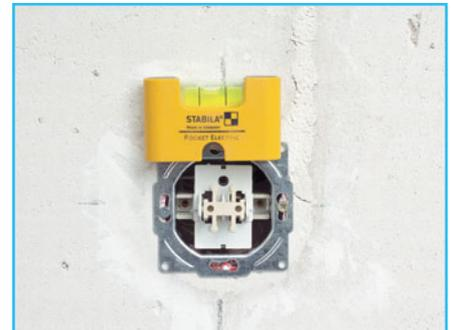
**8** Проверяем правильность установки выключателя с помощью уровня. Это особенно важно, когда выключатели объединяются в блоки: при неправильной установке клавиши начинают заедать.
