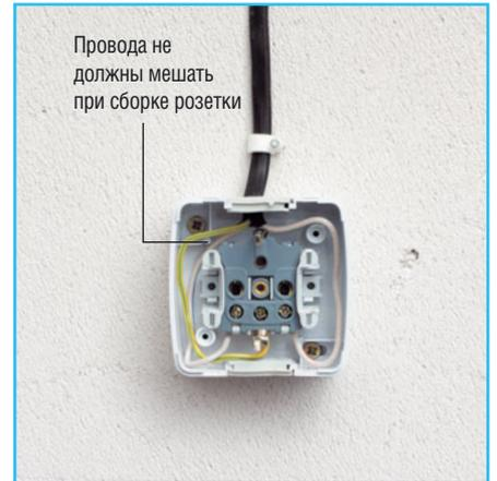
**13** Устанавливаем механизм внутрь корпуса.
