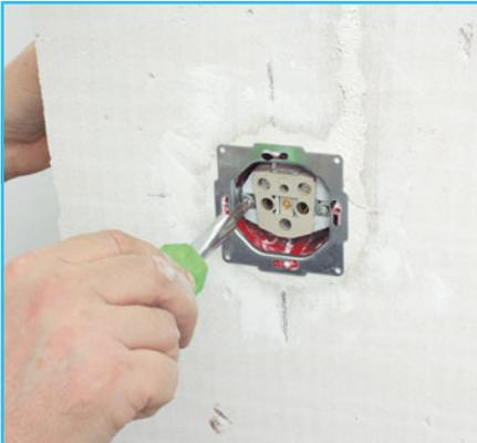
**6** Закручиваем винты с большим усилием, чтобы накрепко зафиксировать розетку.
