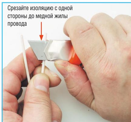
**5** Острие ножа располагаем под малым углом к поверхности провода, чтобы снять изоляцию с внутренних проводов кабеля.
