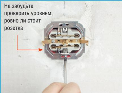
**4** Закрепляем механизм розетки в подрозетнике, используя саморезы. Если в подрозетнике отсутствуют отверстия под саморезы, механизм крепится на распорки.
