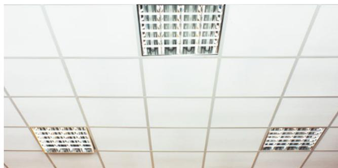
Светильник с люминесцентными лампами
