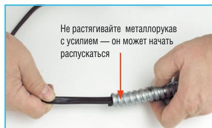
**3** **Протягиваем провод**, чтобы он вышел с другой стороны металлорукава. Иногда металлорукав продается вместе с протяжкой. Тогда следует поступать так, как при протяжке провода через гофру (с. 154, шаг № 3).
