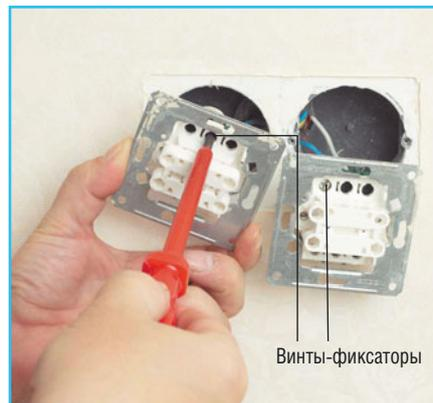
**5** Ослабляем винты, фиксирующие провода.
