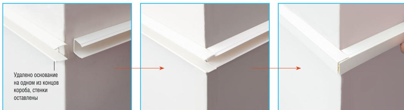
6. При стыковке кабель-канала на внешнем углу поступают наоборот: отрезают основание на одном из концов, оставляя стенки — на них будет держаться крышка. На одной из стыкуемых частей крышек стенки удаляют на ширину кабель-канала либо используют специальные угловые соединители.
