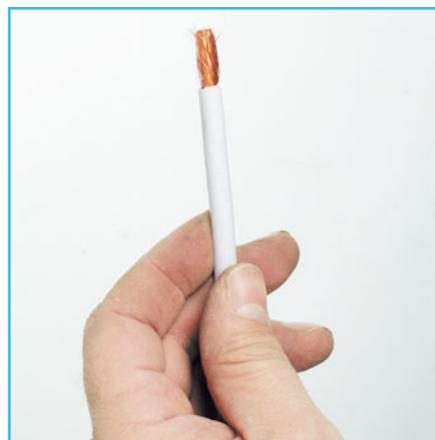
**2** **Снимаем внешнюю изоляцию** кабеля на расстоянии около 1 см. Делаем это аккуратно, чтобы не повредить экран.
