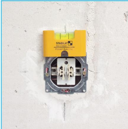
**9** Устанавливаем выключатель, контролируя его положение с помощью уровня. Это делается так же, как и для розетки.
