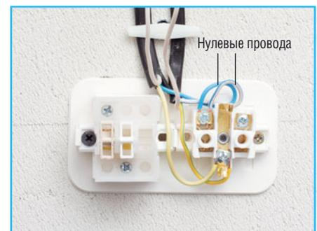
**5** Подключаем нулевые провода (обычно они синего цвета).
