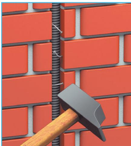
**2** Закрепляем трубу обычными гвоздями или прижимаем, закручивая шурупы (если позволяет материал стены)
