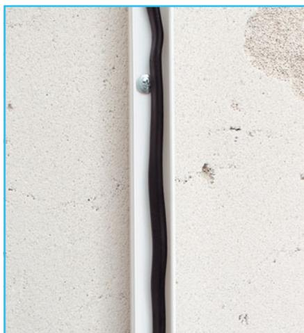
**3** Укладываем провод в короб.
