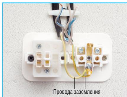
**4** Подключаем провода заземления (обычно они желто-зеленого цвета).
