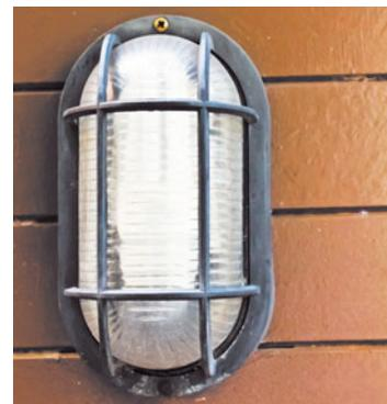
Настенный пылевлагозащищенный светильник с решеткой, обычно устанавливается в технических помещениях
