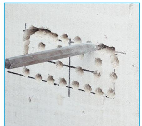
**3** Разбиваем с помощью насадки «лопатка» все перемычки по периметру блока розеток.
