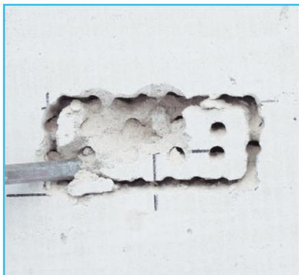
**4 Удаляем материал** из высверленного пространства с помощью лопатки в режиме удара.
