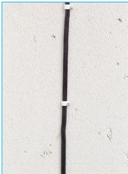
**3** Прибиваем скобами весь провод к стене согласно разметке.
