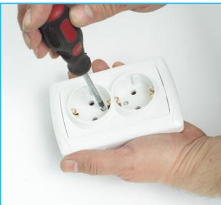
**1** Снимаем наружную панель розетки. Для этого откручиваем два винта посередине передней панели.
