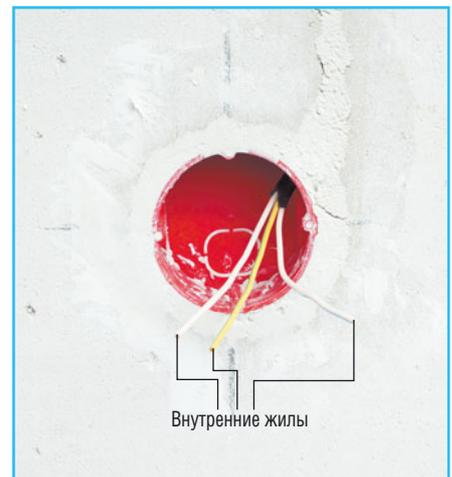
**2** **Снимаем наружную изоляцию** с кабеля. Следим, чтобы изоляция внутренних жил не была повреждена.
