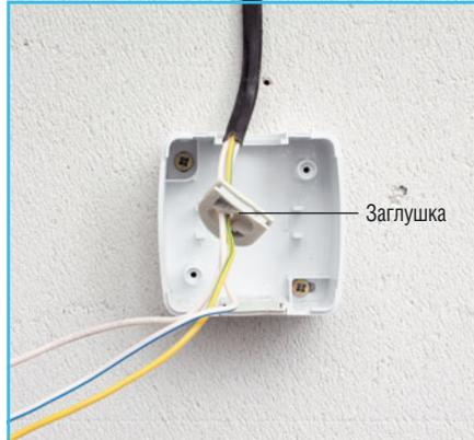
**9** Делаем отверстие в заглушке розетки и надеваем ее на провод.
