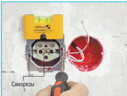
**7 Устанавливаем первую розетку** в подрозетник, контролируя ее положение с помощью уровня. Действия аналогичны установке одиночной розетки, только в данном случае вместо распорок применяют саморезы.
