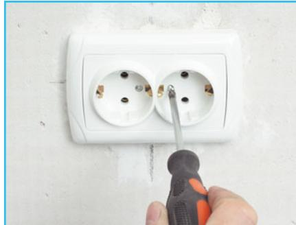
**5** Устанавливаем переднюю панель на розетку. Для этого прикручиваем два крепящих винта.
