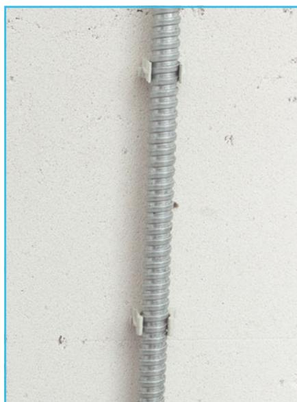
**5** **Устанавливаем металлорукав** с проводом в крепления.
