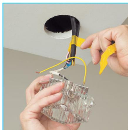
**5 Снимаем изоляцию** с мест подключения светильника, не касаясь самих токопроводящих жил.
