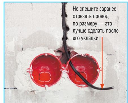
Не спешите заранее отрезать провод по размеру — это лучше сделать после его укладки
