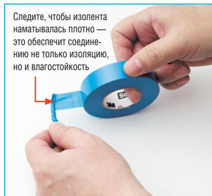
**5** Накручиваем изолянт так, чтобы изоляция выступала за пределы скрутки на расстояние 1 см.
