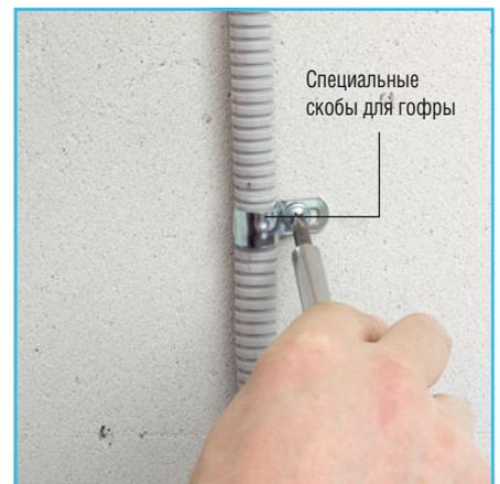
**4** **Закрепляем гофру** на стене с помощью специальных скоб (можно использовать и другие крепления). Прокладываем гофру по размеченному маршруту.
