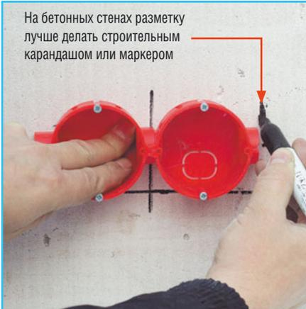
На бетонных стенах разметку лучше делать строительным карандашом или маркером
