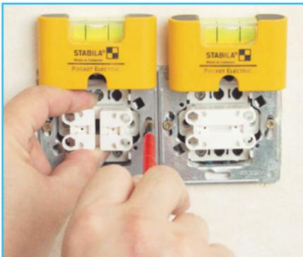
**6** Устанавливаем механизмы выключателей в подрозетники, прикручиваем их винтами. Контролируем, чтобы они стали по уровню и не перекрывали друг друга.
