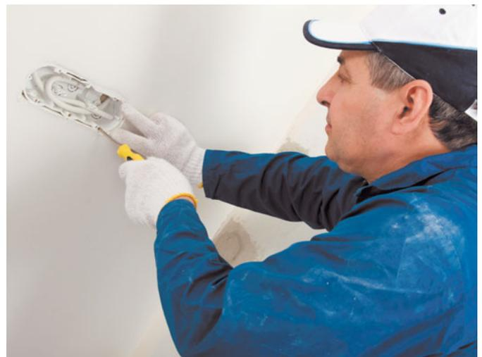
Монтаж распределительной коробки в гипсокартонной перегородке
