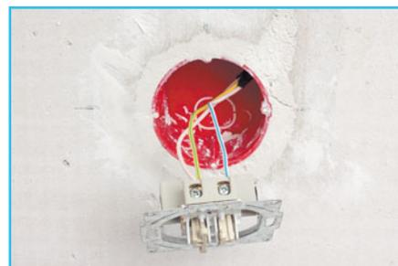
**8** Подключаем два оставшихся провода. В некоторых случаях необходимо соблюдать последовательность подключения проводов, иначе клавиши будут включать не те лампы, которые запланировано.
