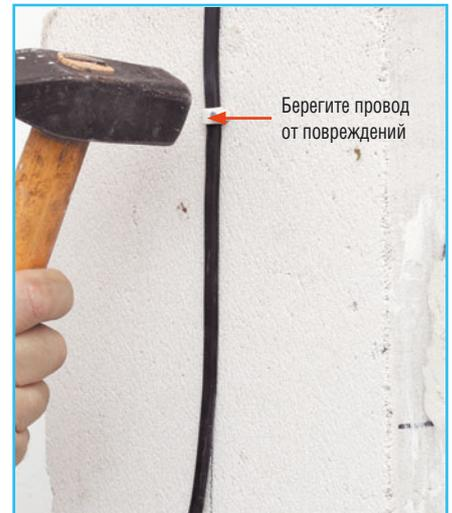
**2** Прибиваем провод к стене с помощью скоб.
