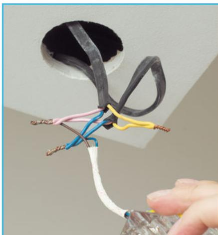
**6 Убеждаемся в отсутствии напряжения** на всех трех скрутках с помощью индикаторной отвертки.
