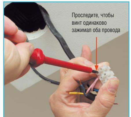
Проследите, чтобы винт одинаково зажимал оба провода
