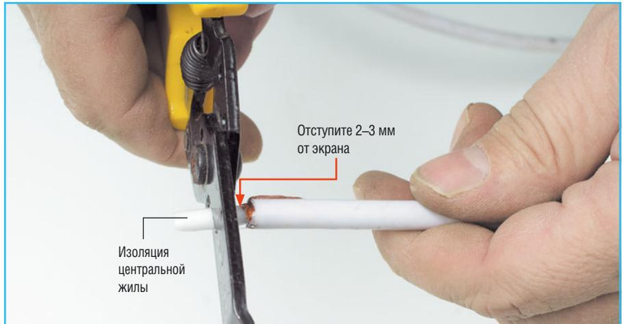
**4 Надрезаем изоляцию** центральной жилы, лучше всего — съемником изоляции, но можно и строительным ножом. В данном случае не надо делать кольцевой надрез, так как в этом месте провод легко переламывается.
