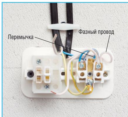
**6** Подключаем фазный провод и перемычку к выключателю.
