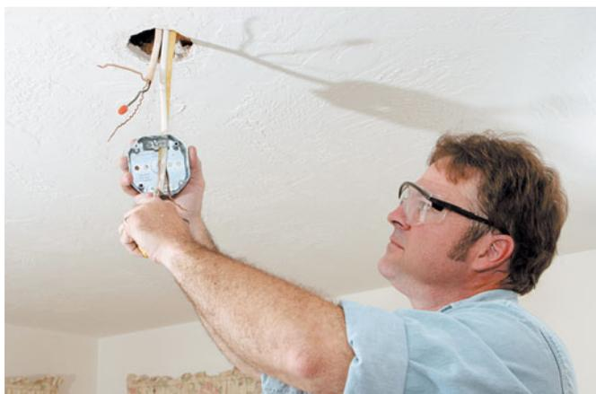
Монтаж коробки крепления под люстру в гипсокартонном потолке
