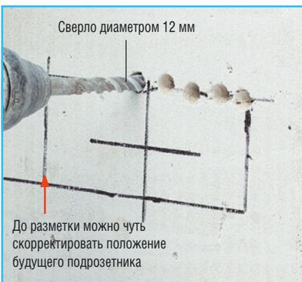
Сверло диаметром 12 мм
