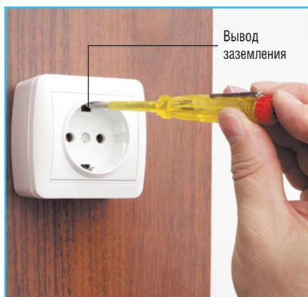
**4** Проверяем отсутствие фазы на корпусе розетки (вывод заземления).
