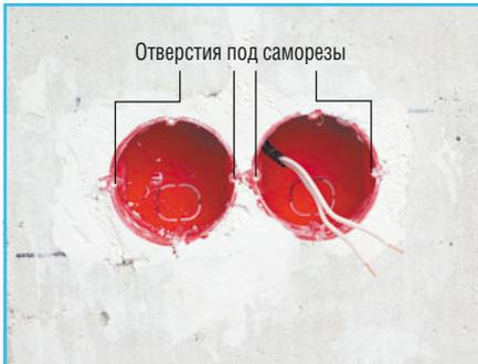
**4 Очищаем подрозетники** от мусора. Если механизм розеток будет крепиться на саморезы, то предварительно очищаем отверстия под саморезы.
