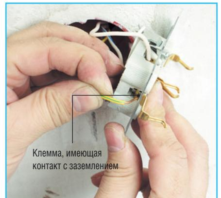
**3** Для подключения провода заземления используем отдельную клемму, которая имеет контакт с заземляющими лепестками розетки.
