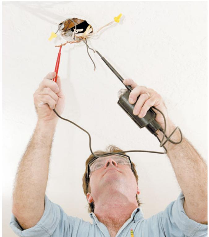
Проверка напряжения на питающих проводах светильника
