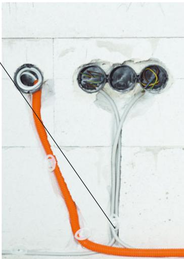
Два вида укладки кабеля в стену: в гофре (слева) и трубе ПВХ
