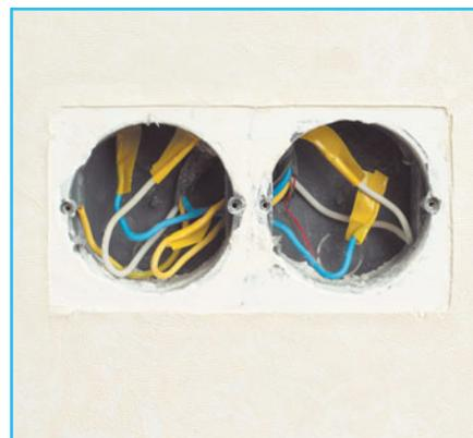
**9 Убираем изолированные провода** в подрозетник, чтобы избежать их повреждений.
