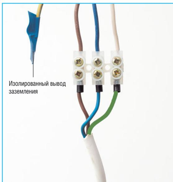
**4** Проверяем надежность соединения проводов в клеммниках, потянув за них и поведя из стороны в сторону.
