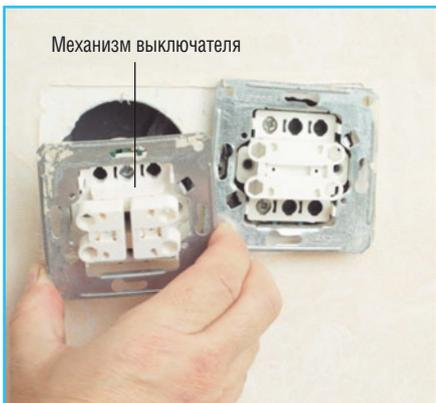
**4** Вынимаем механизм выключателя из подрозетника.
