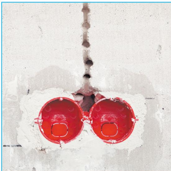
**1** Убеждаемся, что провод входит в штробу. Если мешают какие-то выступы, их следует сбить перфоратором.
