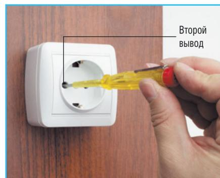
**3** Проверяем наличие фазы на втором выводе розетки. Фаза должна быть только на одном из выводов.
