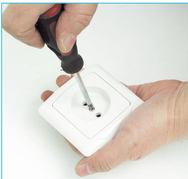
**1** Снимаем наружную панель розетки — для этого откручиваем винт посередине. В некоторых розетках она отщелкивается.
