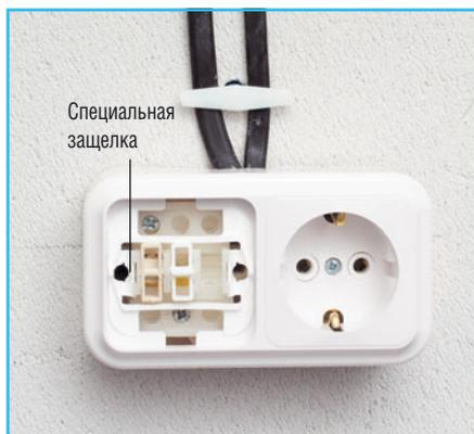
**11** Ставим специальную защелку на выключатель. Следим, чтобы все фиксаторы сработали.
