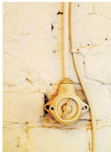
Устаревший способ наружной прокладки: кабель прикреплен к стене электроустановочной скобой и ничем не защищен
