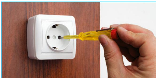
После отключения электричества в квартире индикаторной отверткой **проверьте отсутствие напряжения** на участке, где вы собираетесь работать.
