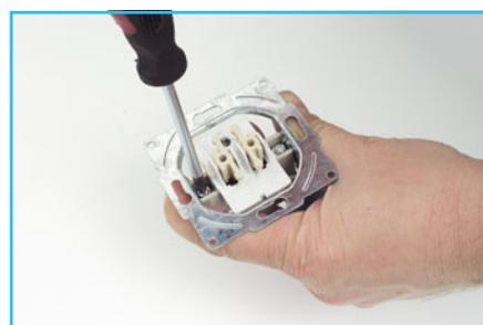
**5** Снимаем распорки, чтобы не мешали (если выключатель ставится на саморезы).
