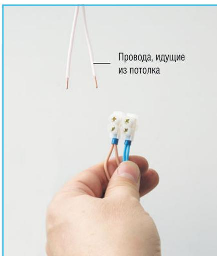
**3** **Поднимаем** светильник для подключения проводов, идущих из потолка.
