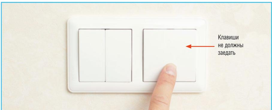
**9** Включаем автомат и проверяем работу выключателя.
