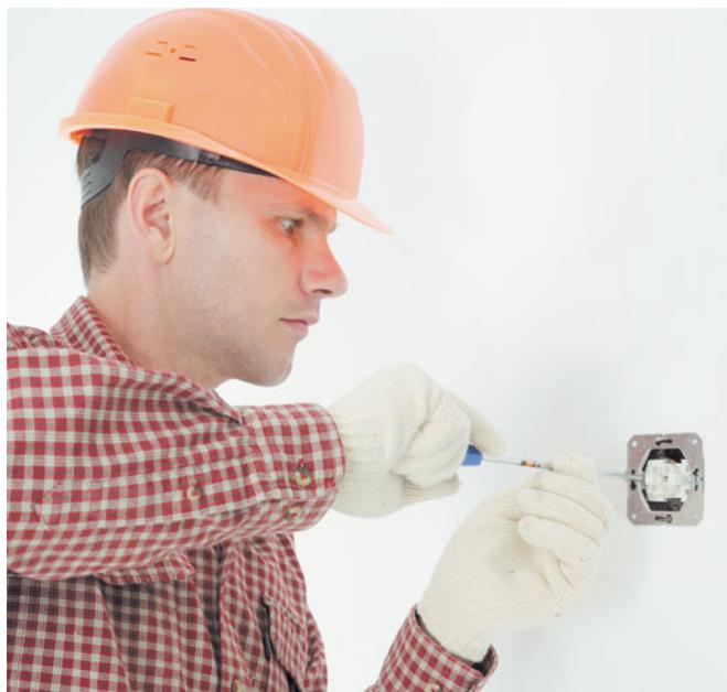
Завершающий этап в установке выключателя: колодку прикручивают шурупами к установочной коробке
