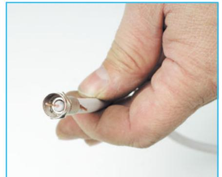
**7 Накручиваем** до тех пор, пока изоляция центрального провода не окажется на указанном уровне.
