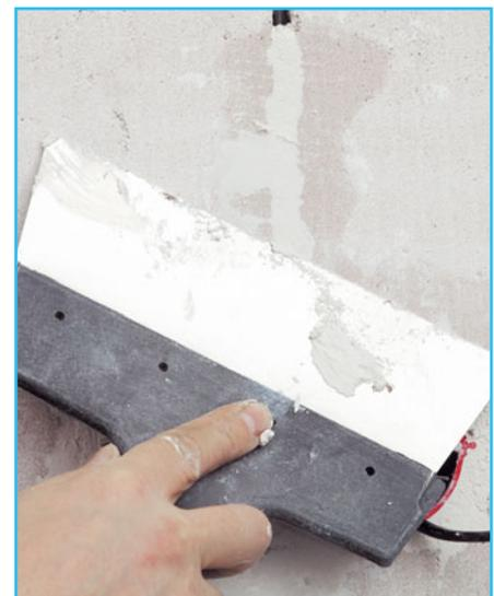
**5** Срезаем излишки гипса, выравнивая стену широким шпателем.
