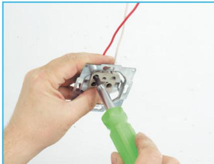
**5 Прикручиваем** заготовленные провода к механизму первой розетки.
