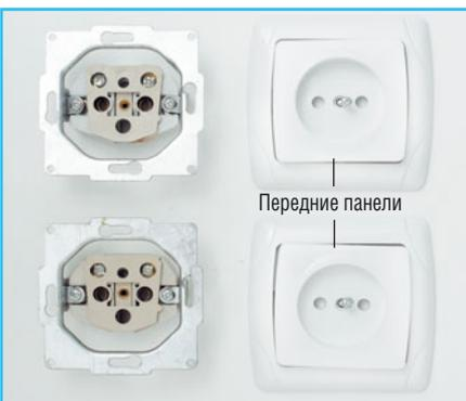
**1** Снимаем передние панели с розеток. При установке блока розеток используются внутренние части панели. Вместо внешних рамок вставляется общая рамка на две розетки.
