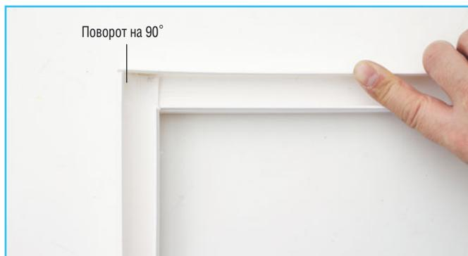
2. Поворот на 90° осуществляют, отрезая концы кабель-канала под 45° с помощью стусла или же так, как показано на фото: на одном куске удаляют ближнюю к стыку стенку (на ширину основания), а на другом отрезают часть основания и ближнюю к стыку стенку (оставив одну дальнюю стенку).
