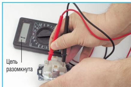
**6** Прозваниваем выключатель, используя мультиметр. При замыкании он показывает нули, при размыкании — единицу. Это необходимо, чтобы выключатель включался (замыкался) при включении вверх. Так же определяем общую клемму, к которой подключены оба контакта.
