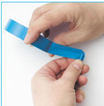
**7** Фиксируем согнутый участок, наматывая изолянт в обратном направлении до конца скрутки.
