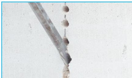
**4** С помощью лопатки в перфораторе ломаем перемычки между отверстиями и расширяем штробу до нужных размеров. Необходимо, чтобы над уложенным проводом еще оставалось минимум 5 мм для гипса.
