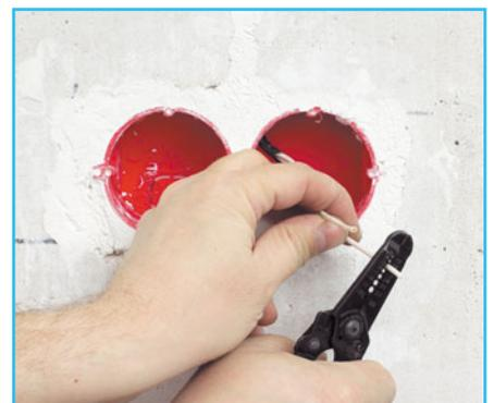
**3** Снимаем внешнюю изоляцию с подводящего кабеля и зачищаем провода.
