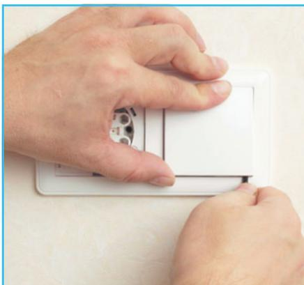
**1** Снимаем клавиши выключателя, аккуратно поддевая каждую отверткой.
