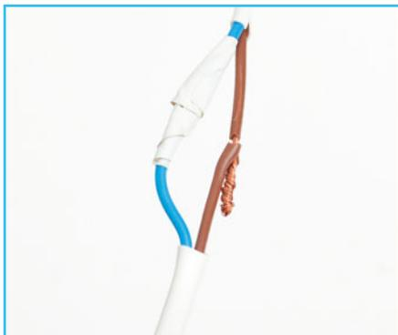
**6** **Скручиваем** второй провод, пропаяв его перед изоляцией для надежности. Для пайки используем паяльник, флюс и припой. Можно применять другие методы соединения проводов.
