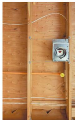
Если проводку предполагается спрятать в потолки, полы или перегородки, ее нужно поместить в пластиковые трубы или лотки — это требование пожарной безопасности.
