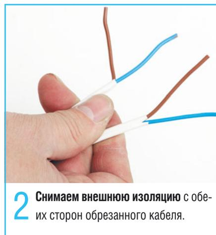
**2** Снимаем внешнюю изоляцию с обеих сторон обрезанного кабеля.
