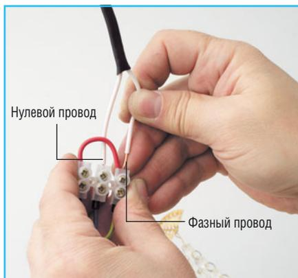
**5** Зажимаем в одном гнезде клеммника второй конец перемычки и фазный провод, который идет на светильник, а нулевой провод зажимаем в среднем выводе клеммника.
