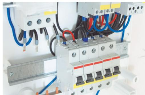
Контакты автоматических выключателей соединены однофазной шиной-гребенкой
