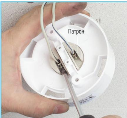
**6** Подключаем провода к патрону или клеммнику в зависимости от конструкции светильника. Зажимаем провода достаточно сильно, но не чрезмерно, поскольку можно сорвать резьбу.
