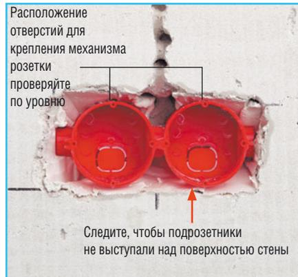
Расположение отверстий для крепления механизма розетки проверьте по уровню
