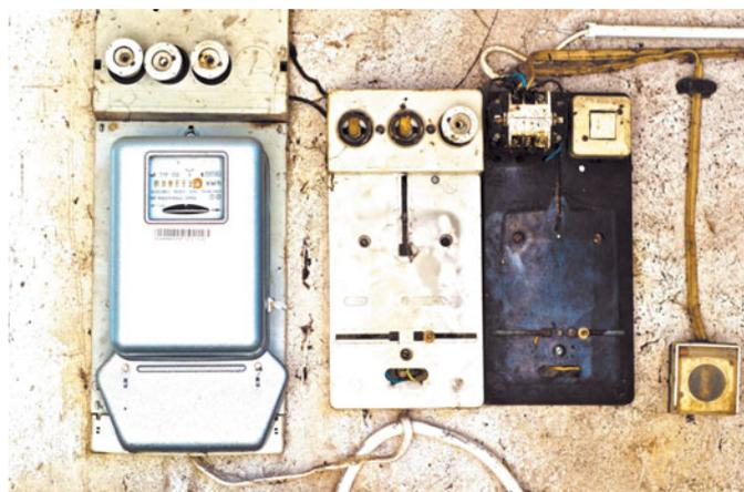
Пример устаревшего квартирного щита: механический счетчик, автомат отключения и несколько предохранителей (если у вас в квартире стоит подобный щит, лучше заменить его во избежание аварийных ситуаций)
