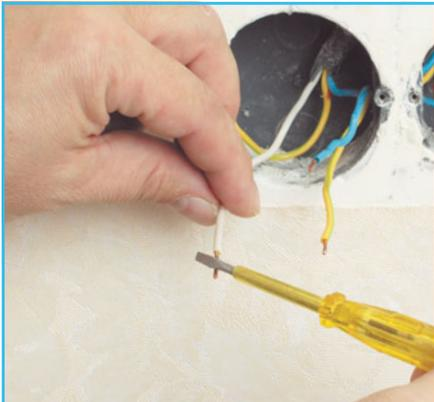
**3** Проверяем отсутствие напряжения индикаторной отверткой на всех подводящих проводах.
