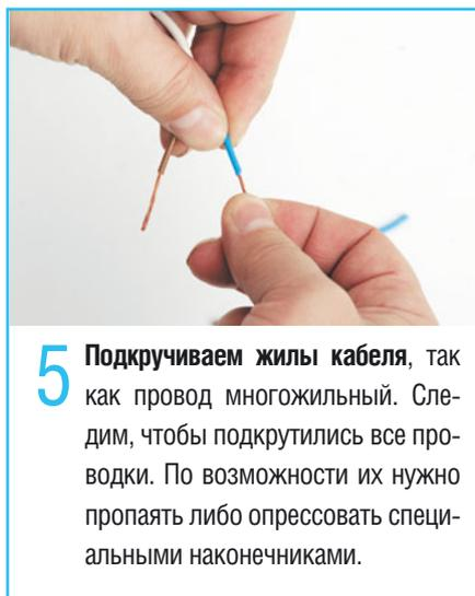
**5** Подкручиваем жилы кабеля, так как провод многожильный. Следим, чтобы подкрутились все проводки. По возможности их нужно пропаять либо опрессовать специальными наконечниками.
