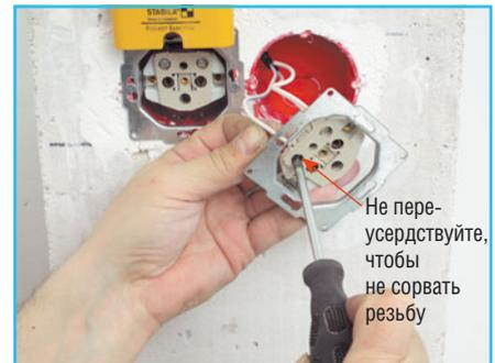
**9 Хорошо зажимаем провода** в розетке.
