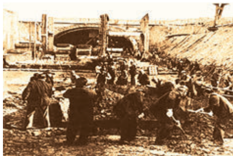
Toshkent metropolitenining qurilishi
