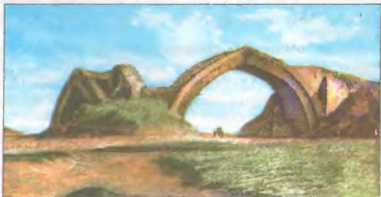
Мост-водораздел, построенный на реке Зарафшан
