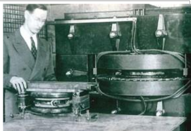
2.4-rasm. D.Kerst o'zining betatronlari oldida: 2,3 MeV dagi kichik va 25 MeV energiyadagi katta betatronlar.
