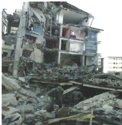
70-расм. Зилзила тўфайли вайрон бўлан кўп қаватли уйнинг кўриниши.
