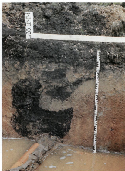
2.30 Поперечное сечение широкой траншеи керамического дренажа. Обратная засыпка дренажной траншеи на дерново-глеевых почвах обогащена гумусированным мелкоземом. Котельнич. "Ивакинские пашни". Кировская обл.
