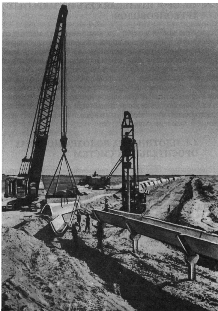
Рис. 48. Монтаж лотковой оросительной сети
