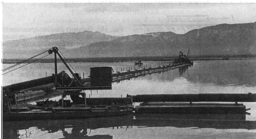
Рис. 104. Разработка пульпы землесосными снарядами на р. Риони и ее подача на осушаемую территорию для рефулирования
