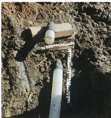
2.29 Подключение пластмассовой дрены к керамическому коллектору
