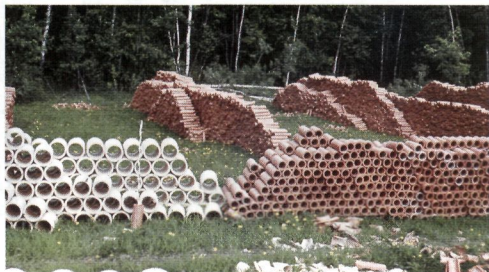
2.14 Дренажные и коллекторные керамические трубы на строительстве закрытой осушительной системы. Запад Московской обл.
