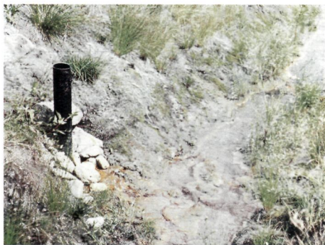
2.21 Разгрузочная скважина в дне осушительного канала при заболачивании почв напорными водами. Долина р. Сусунай. Сахалин
