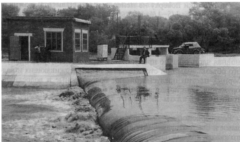
Рис. 51. Водосливная плотина из мягких (прорезиненных) оболочек
