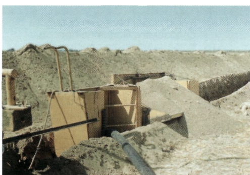
1.23 Формирование песчаного траншейного фильтра для усиления приточности воды к пластмассовой дрене. Джезакская степь. Узбекистан
