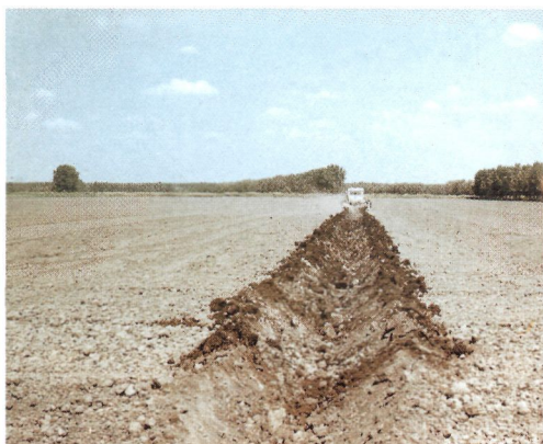
1.25 Устройство временного оросителя треугольным канавокапателем. Право-Егорлыкская оросительная система. Ставропольский край
