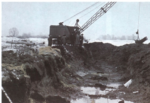
2.15 Строительство регулирующей сети осушителей и коллекторной сети на тяжелых оглеенных дерново-подзолистых почвах. Запад Московской обл.
