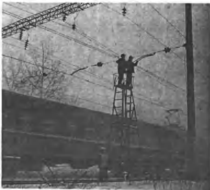
7.7-rasm. Kontakt tizimlarni joriy ta'mirlash.
