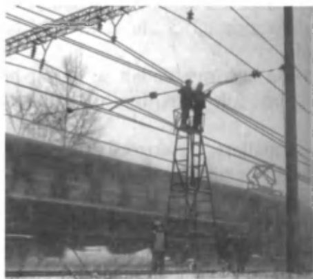
7.7-rasm. Kontakt tizimlarni joriy ta'mirlash
