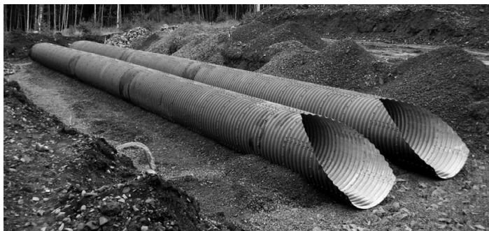
Рис. 12.3. Общий вид гофрированных труб со срезом
