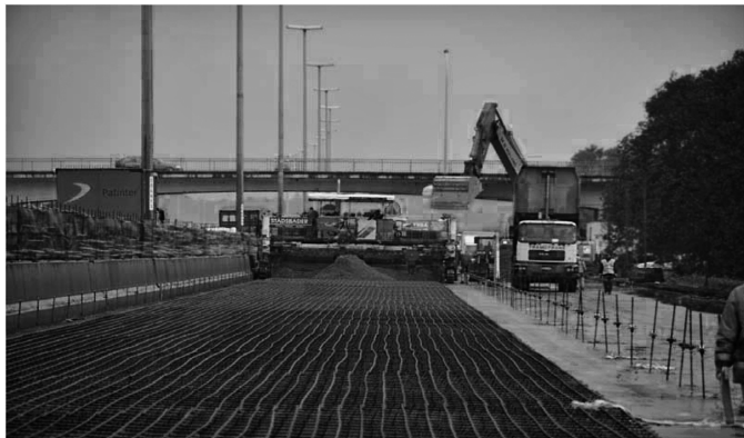
Рис. 20.13. Устройство непрерывно армированного цементобетонного покрытия
