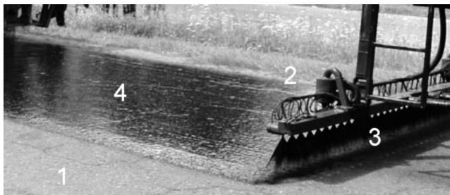
Рис. 19.7. Нанесение битумной эмульсии:
