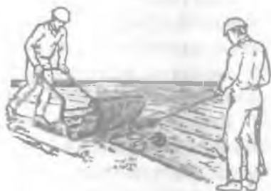
10.1-rasm. Eritiladigan ruberoid asosida tomni gidroizolatsiyalash.
