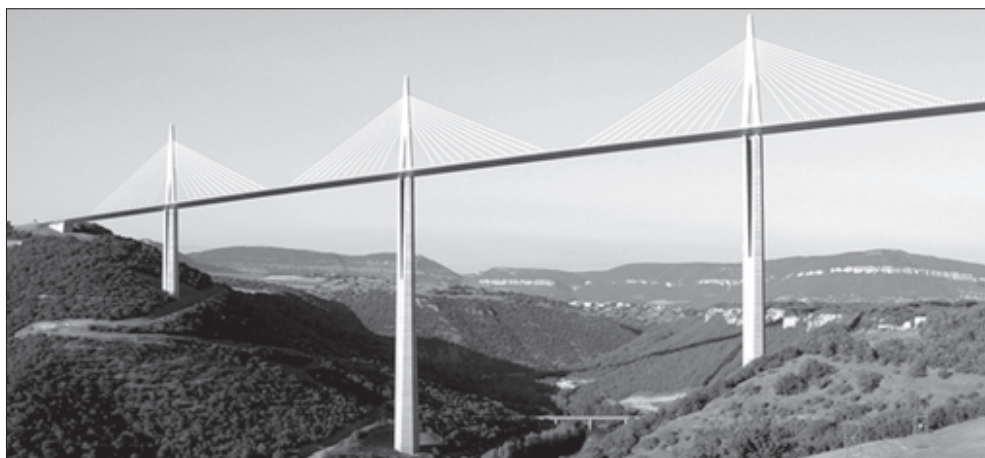
Рисунок 2.3. Виадук Мийо (le Viaduc de Millau). Шесть центральных пролётов Viaduc de Millau имеют длину — 342 м каждый, а два крайних — по 204 м. Максимальная высота дорожного полотна над землёй — 270 м, максимальная высота пилонов — 343 м
