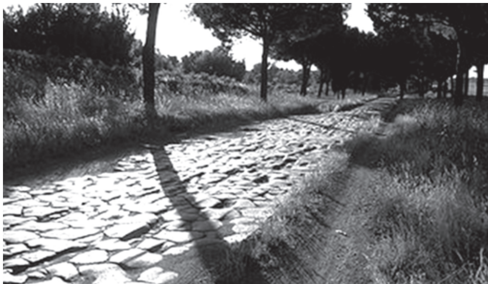
Рисунок 1.2. Дорога в Италии (Аппиева дорога), построенная в 312 году до н.э. и сохранившаяся до наших дней.
