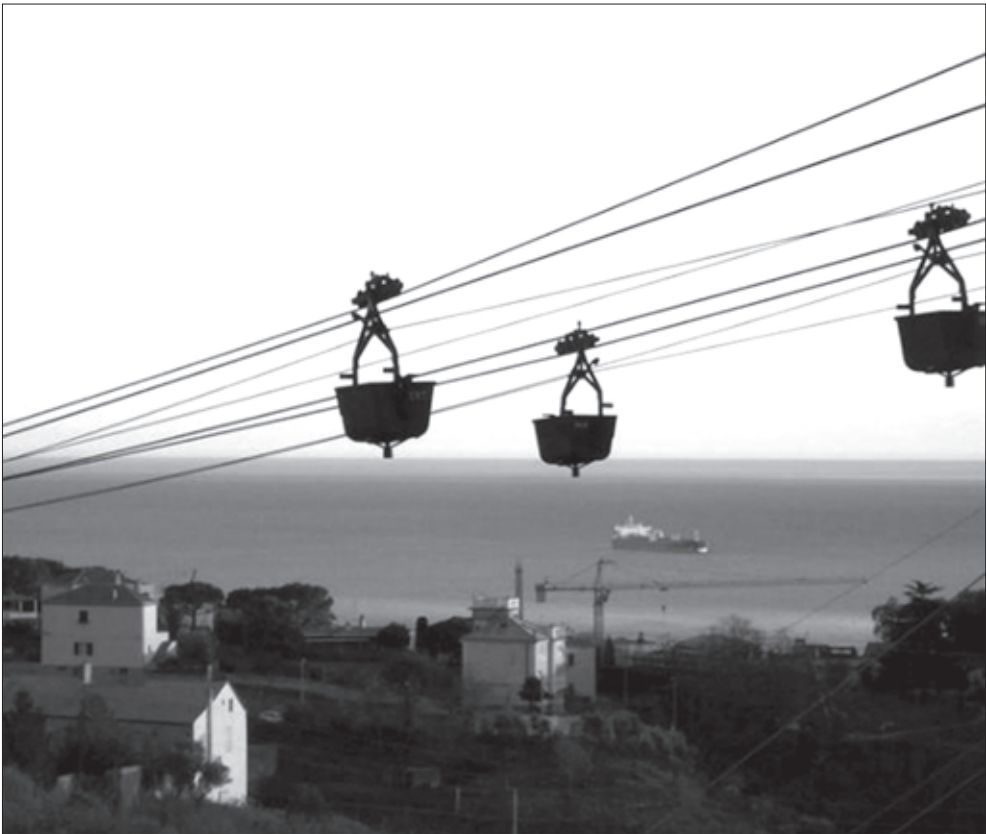
Рисунок 9.1. Общий вид двух-канатной подвесной дороги
