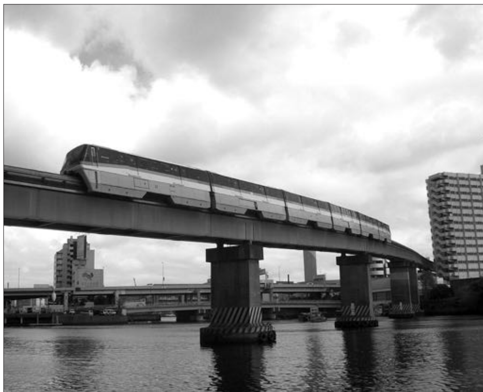
Рисунок 10.4. Монорельсовая дорога, Токио, Япония
