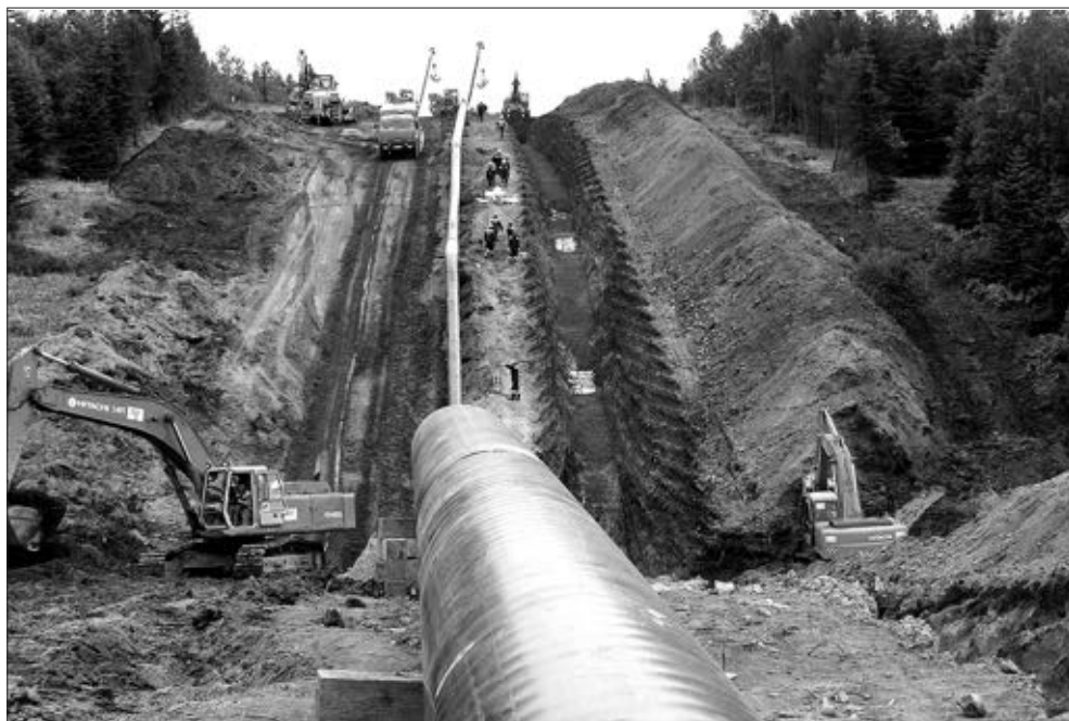
Рисунок 7.1. Строительство линейной магистрали наземного трубопровода
