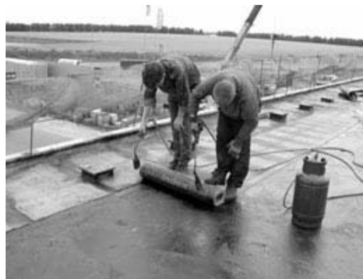
Kirish qiyin bo'lgan joylarning (birlashadigan joylar, deformatsion choklar, perila va xavfsizlik to'siqlari ostidagi joylar) gidroizolyatsiyasi
