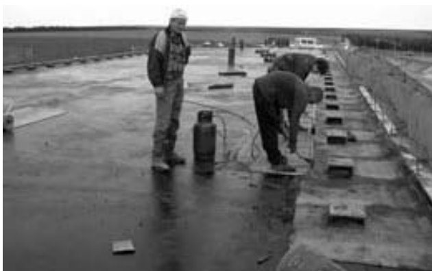
Kirish qiyin bo'lgan joylarning (birlashadigan joylar, deformatsion choklar, perila va xavfsizlik to'siqlari ostidagi joylar) gidroizolyatsiyasi
