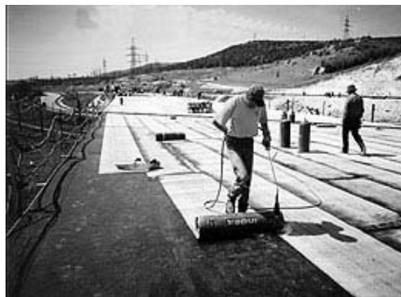
Rulonli membran tipidagi eriydigan «Testudo» gidroizolyatsiyasini yotqizish
