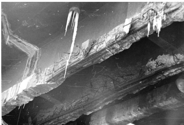
12-rasm. 3376 km dagi temir yo'l o'tkazgichi to'sini ishchi armaturasining ochilib qolishi
