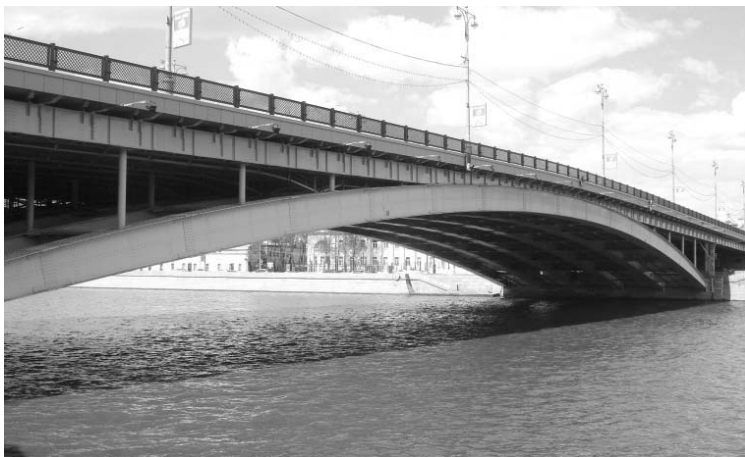
25-rasm. B. Ustinskiy ko'prigining rekonstruksiyasi, Moskva sh. Harakat qismining gidroizolyatsiyasi, 10 000 kv.m ga yaqin. Quyidagi materiallardan foydalanildi: Icosit® EG1, Icosit® Haftmasse
