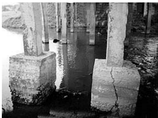
Qoziq mahkamlamasi bandaji (kamari)dagi yoriqlar
