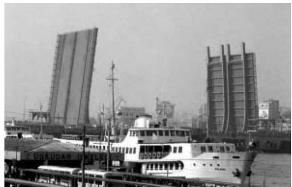
21-rasm. Istanbul, Turkiya: yangi ko'prikning tavaqasi Icosit® EG System bilan himoyalangan. Jami 23.000 m 2 qoplangan
