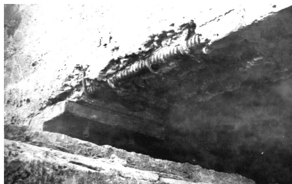
10-rasm. Tangensial tayanch qismlari asosining siljishi va to'sin armaturasining ochilib qolishi
