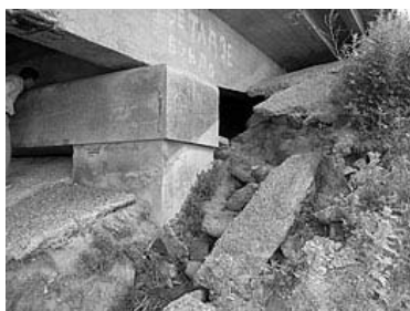
Qoziq mahkamlamasi bandaji (kamari)dagi yoriqlar
