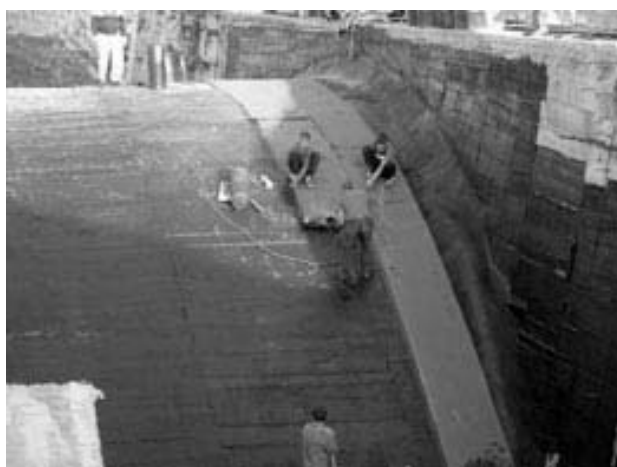
Kirish qiyin bo'lgan joylarning (birlashadigan joylar, deformatsion choklar, perila va xavfsizlik to'siqlari ostidagi joylar) gidroizolyatsiyasi
