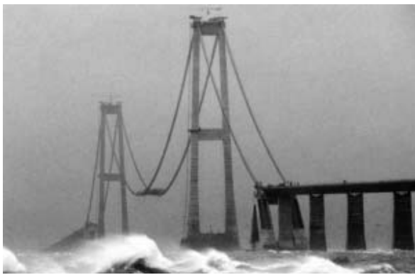
20-rasm. Daniyadagi katta ko'prik: xizmat yo'lakhasi yuqori mexanik mustahkamlik va kuchlarga bardoshli bo'lgan Elastomastic TF material bilan qoplangan
