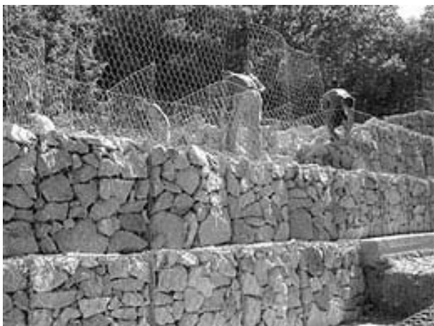
Gabionli qutilarni to'ldirish va toshlar bilan to'kish
