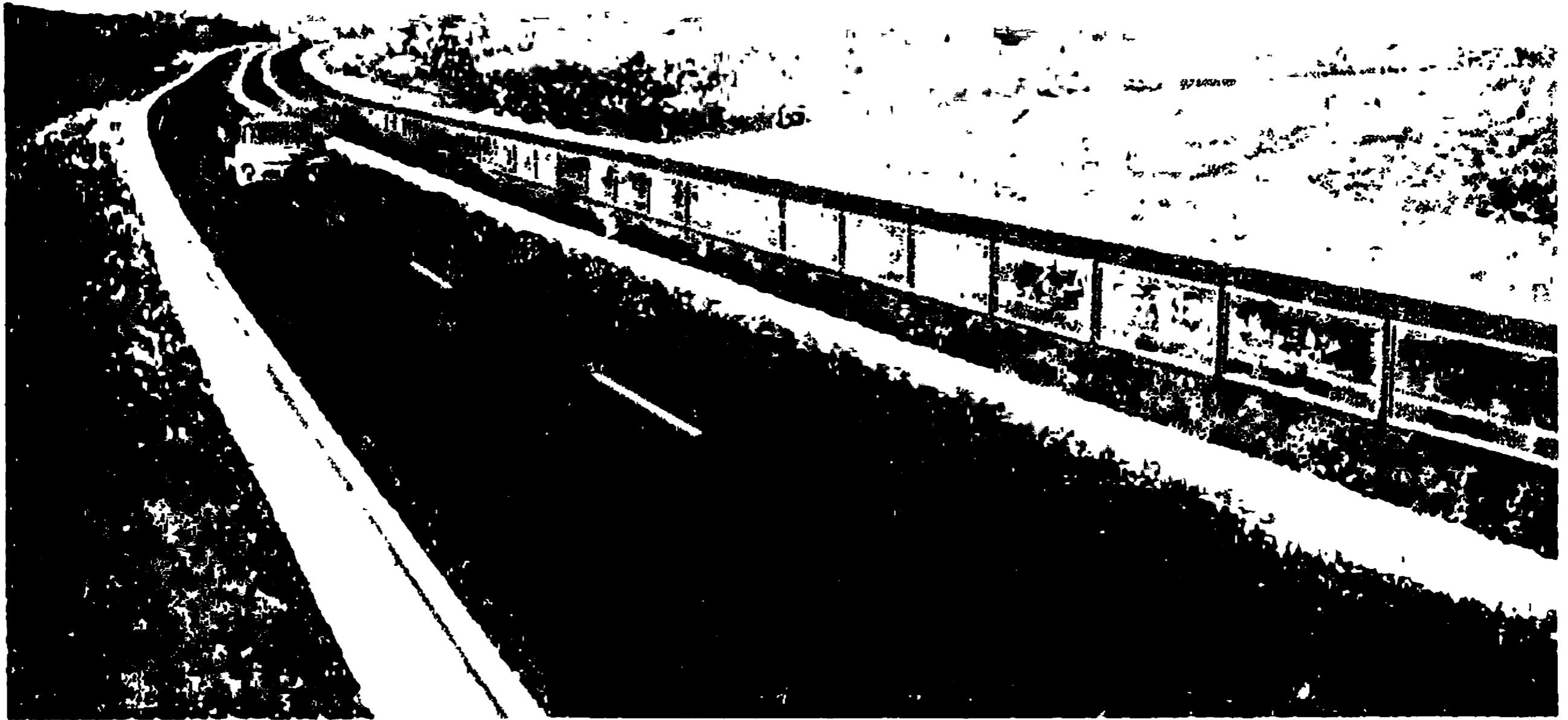
Рис. 9.24. Экран на разделительной полосе для защиты от ослепления
