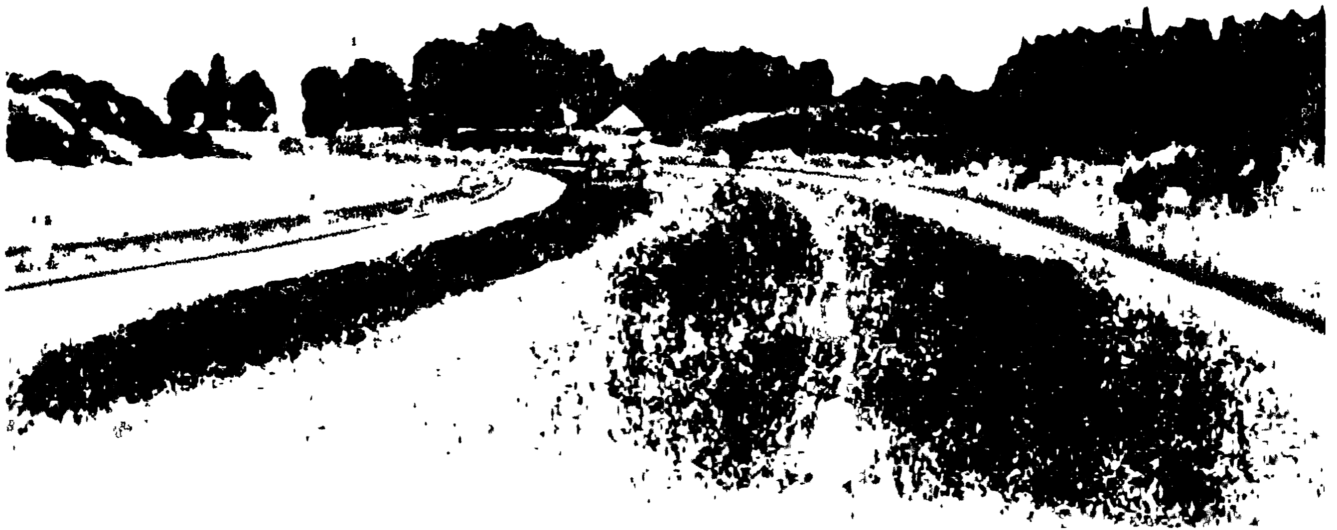
Рис. 8.8. Дополнительная полоса на подъеме (на фото слева)
