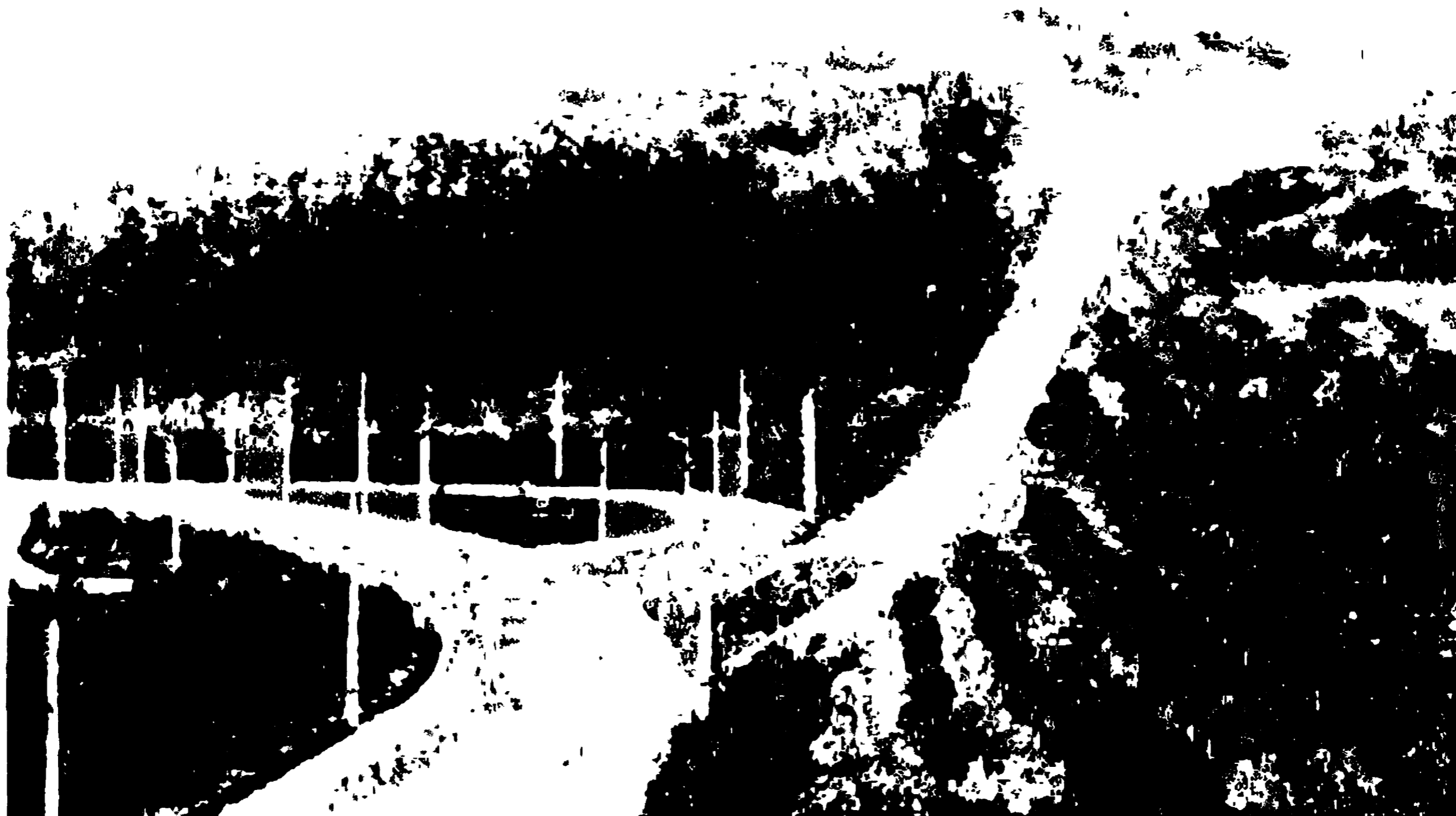
Рис. 8.10. Аварийный съезд в горной местности (на фотографии виден также участок дороги на кривой малого радиуса, брошенный при реконструкции дороги)
