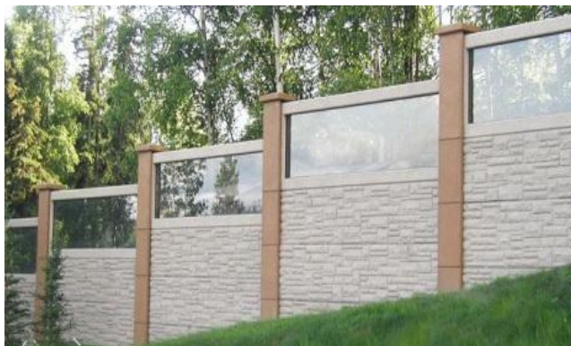
1.12-расм. Бойлама нишабликли йўл участкасига бир хил баландликдаги панеллардан шовқиндан ҳимояловчи экранларни жойлаштириш.
