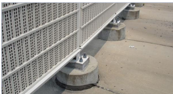
8.29-расм. Шовқиндан химояловчи экран остида нов (а) ёки туйнук (б) қурилмаси билан сув четлатишни ташкил қилиш.
