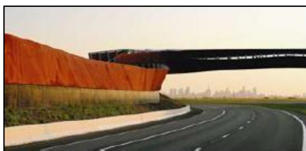
1.8-расм Экраннинг юқори тўлқинли қисми унинг баландлигини камайтиради.
