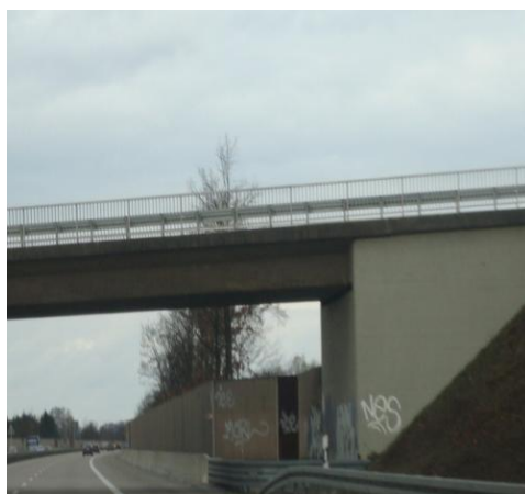
1.15–расм. Шовқиндан ҳимояловчи темир бетон экраннинг сунъий иншоот билан боғланишининг дастлабки қисми.
