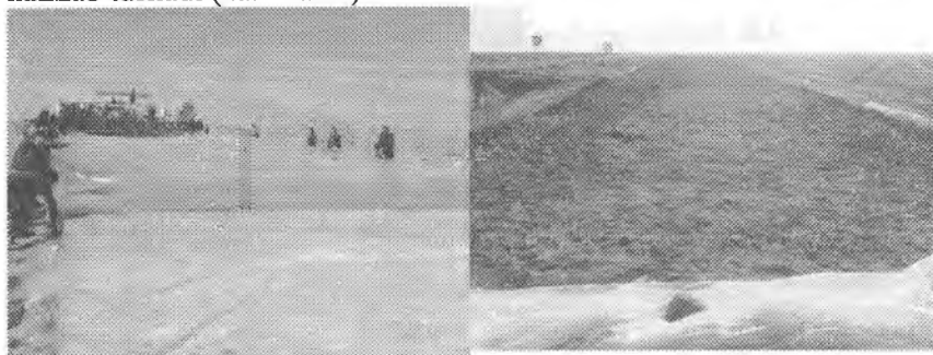
4.24-rasm. Yuqori haroratlarda yotqizilgan qoplama qarovi uchun bajariladigan ishlar ketma-ketligi
