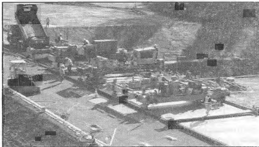
4.8-rasm. Beton qoplamasini rel's qoliplar yordamida qurish texnologiyasi
