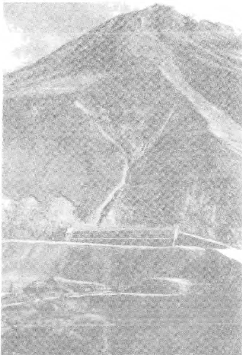
31.41 – расм. Қордан ҳимоялаш галереяси. Ёнбағирдан юқорида кўчки йиғиладиган ҳовза яхши кўриниб турибди.
