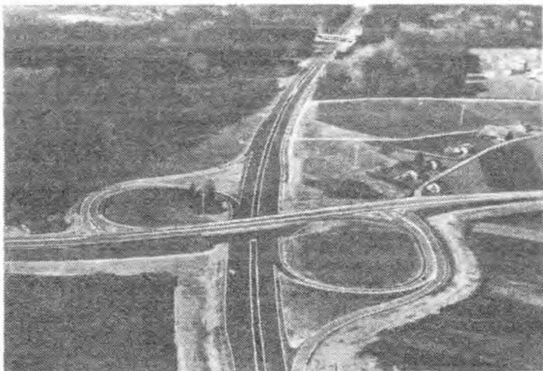
13.15-расм. Тўлиқмас «Беда барги» ли кесишишнинг умумий кўриниши.
