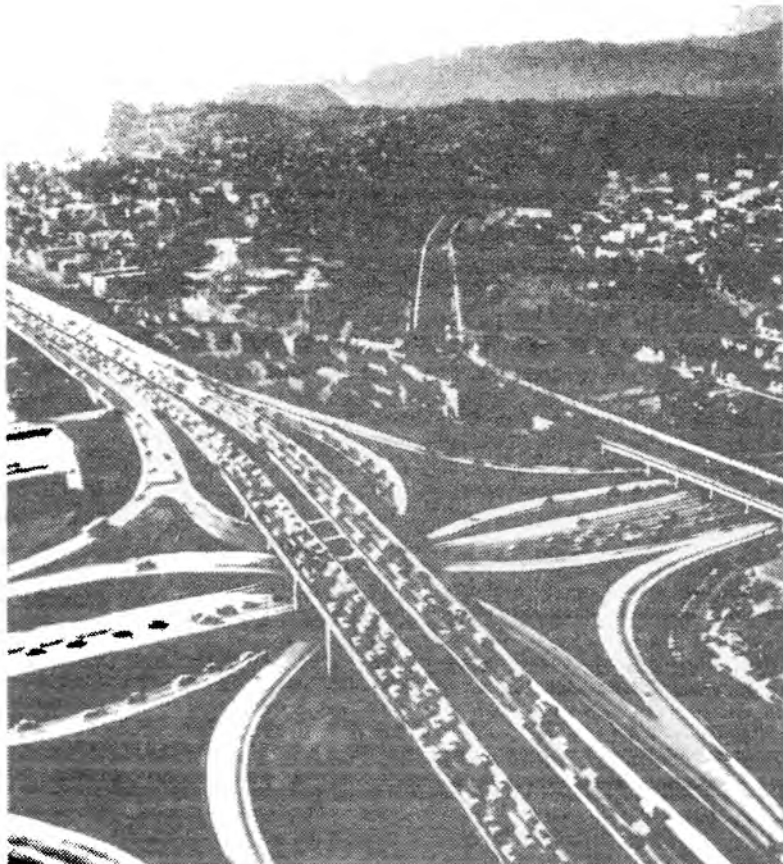
13.19-расм. Чапга бурилишли турдаги тўрт сатҳли кесишиш.
