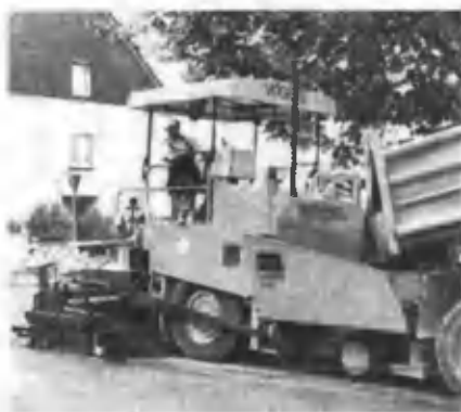
5.1.4-rasm. Asfaltyotqizish jarayoni.
