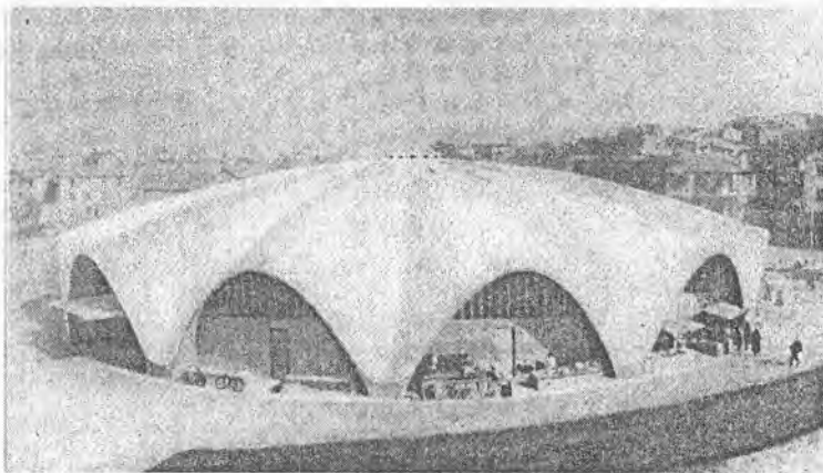
Рис. 15.6.4.8. Пример покрытия рынка куполом волнистой формы (Руайан, арх. Симон Морисо): а — общий вид, б — план
