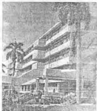
Рис. 3.6. Примеры солнцезащитных устройств в районах с жарким климатом: а — сплошная солнцезащита на галерее административного здания, б — коробчатая система, примененная на здании правительства в Чандигархе (Индия). Использование галерей и открытых рекреаций в качестве солнцезащиты: в — старое медресе, г — школа им. Димитрова в Ташкенте, д — старая типовая школа, е — здание общеобразовательной школы (Куба)
