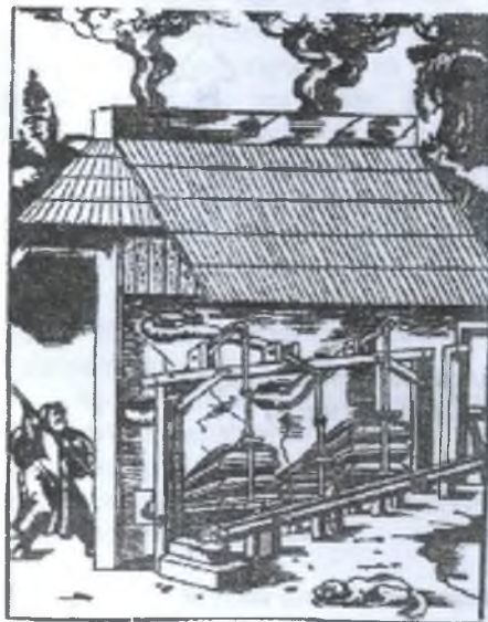
Катта пуфлагичлар ёрдамида металл суюлтириш
